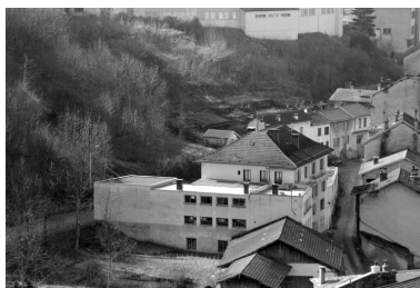
Façades postérieure et latérale droite.
