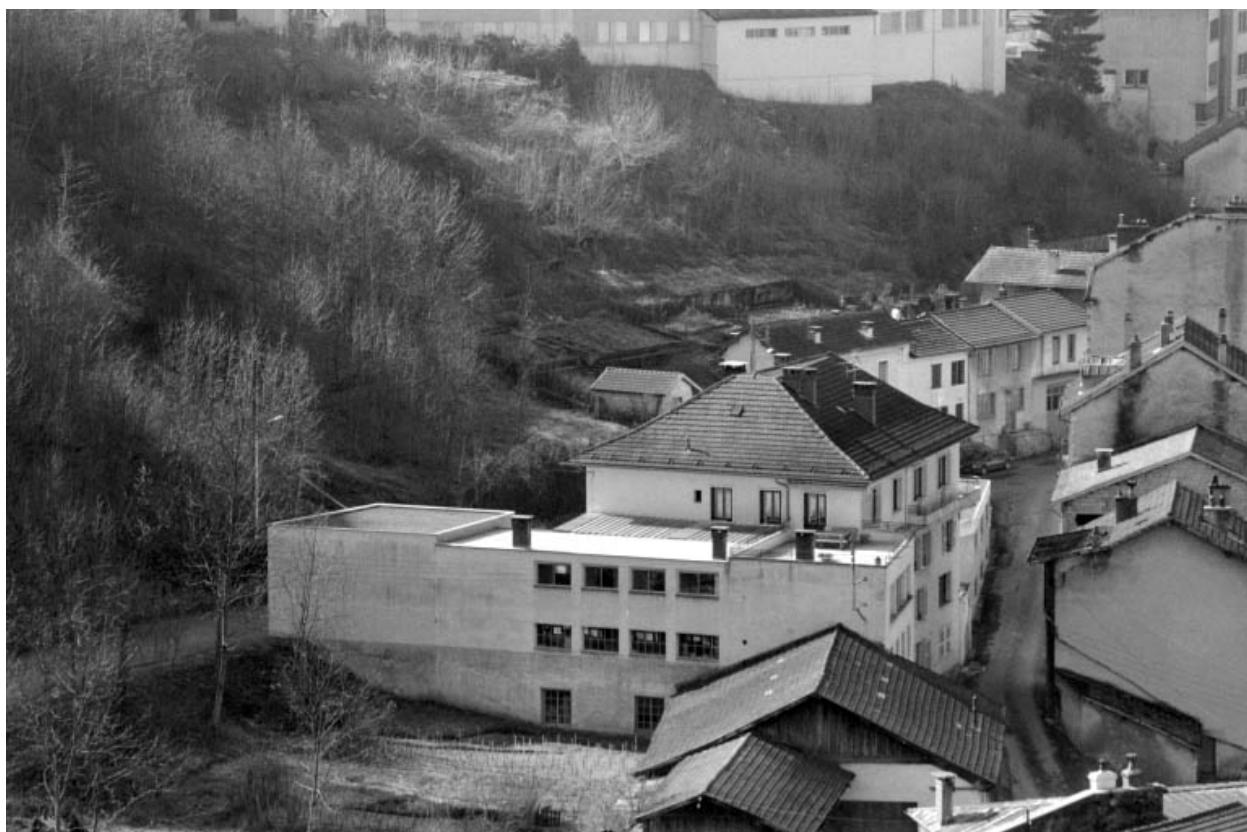
Façades postérieure et latérale droite.
