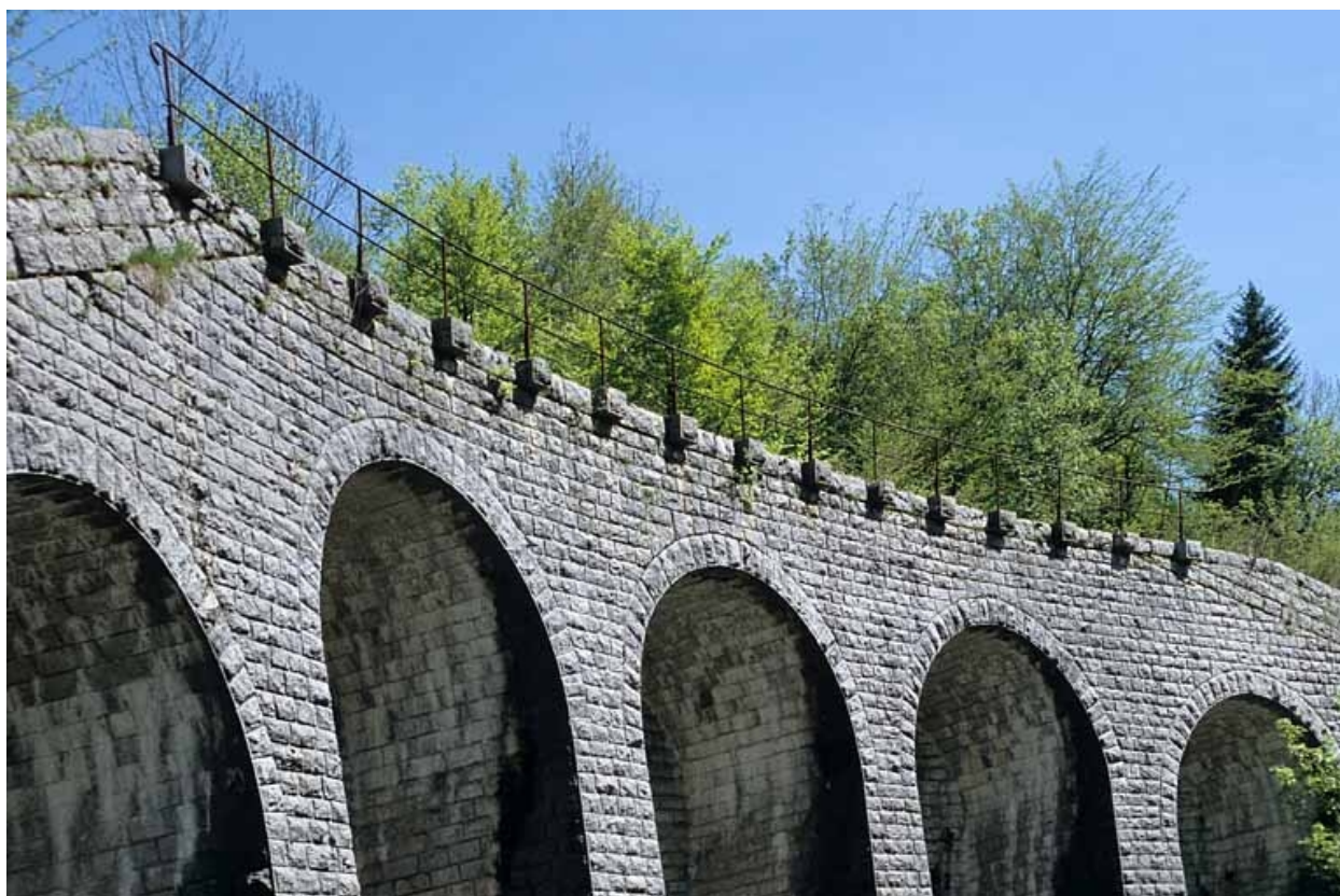
Garde-corps et partie supérieure des arcades.
