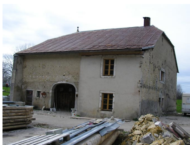
Ferme située au lieu- dit Sous le Mont noir. Phot. Marie-Pierre Reynet IVR43_20083900182NUC1A
