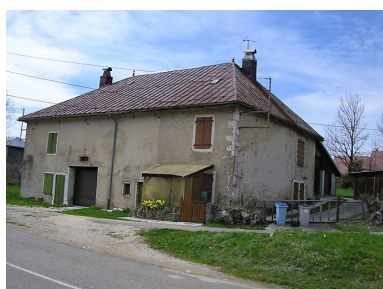
Ferme située au lieu-dit Le Maréchet. Phot. Marie-Pierre Reynet IVR43_20083900177NUC1A
