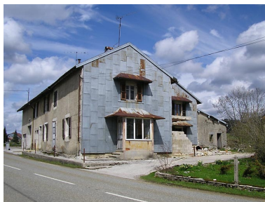
Ferme située au lieu-dit Les Martins. Phot. Marie-Pierre Reynet IVR43_20083900121NUC1A
