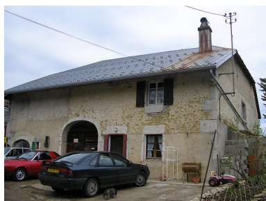
Ferme située au lieu- dit Sous le Mont noir. Phot. Marie-Pierre Reynet IVR43_20083900184NUC1A
