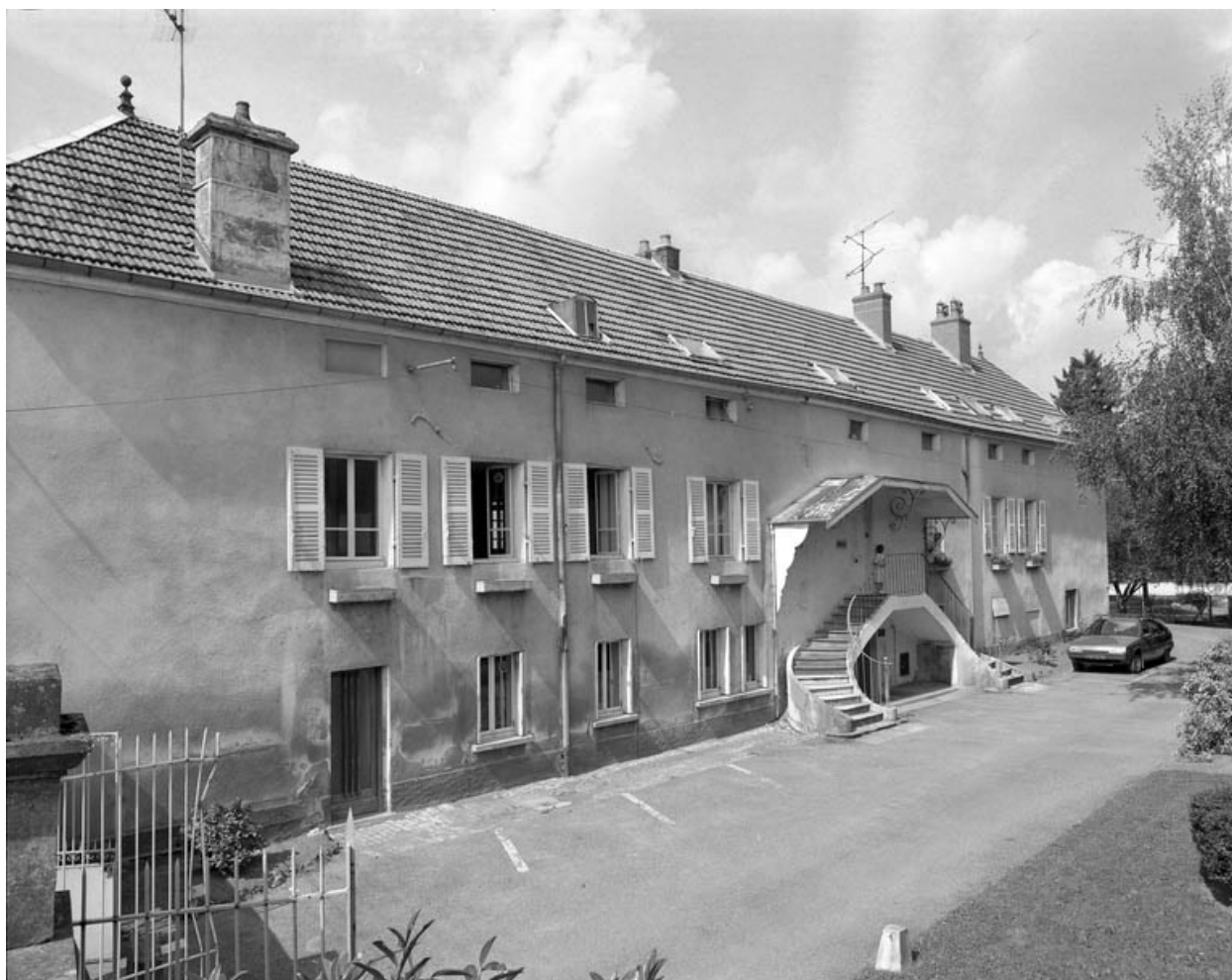
Façade latérale droite.
