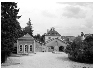
Remises et dépendances à droite de l'arrière-cour. Phot. Yves Sancey IVR43_19887000073X
