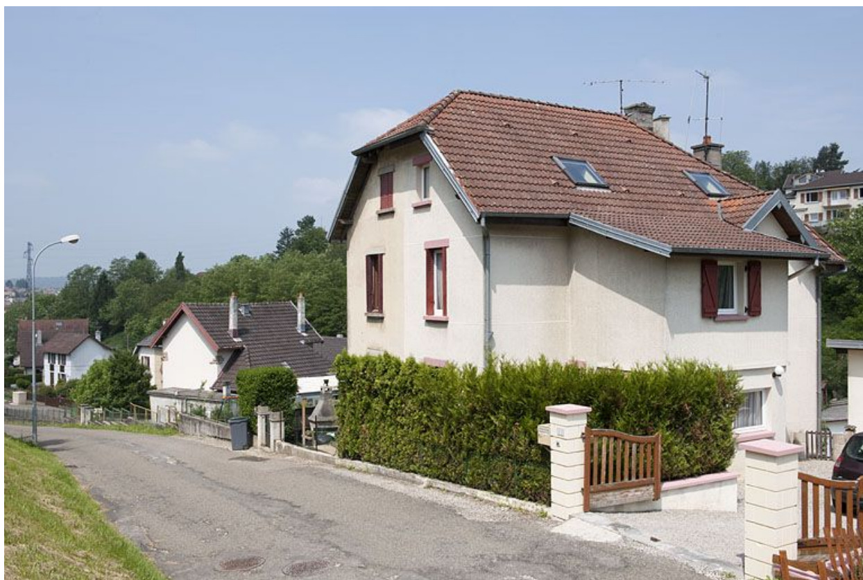
Maison jumelée. Vue de trois quarts droite.
