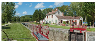
Vue d'ensemble du site d'écluse.
