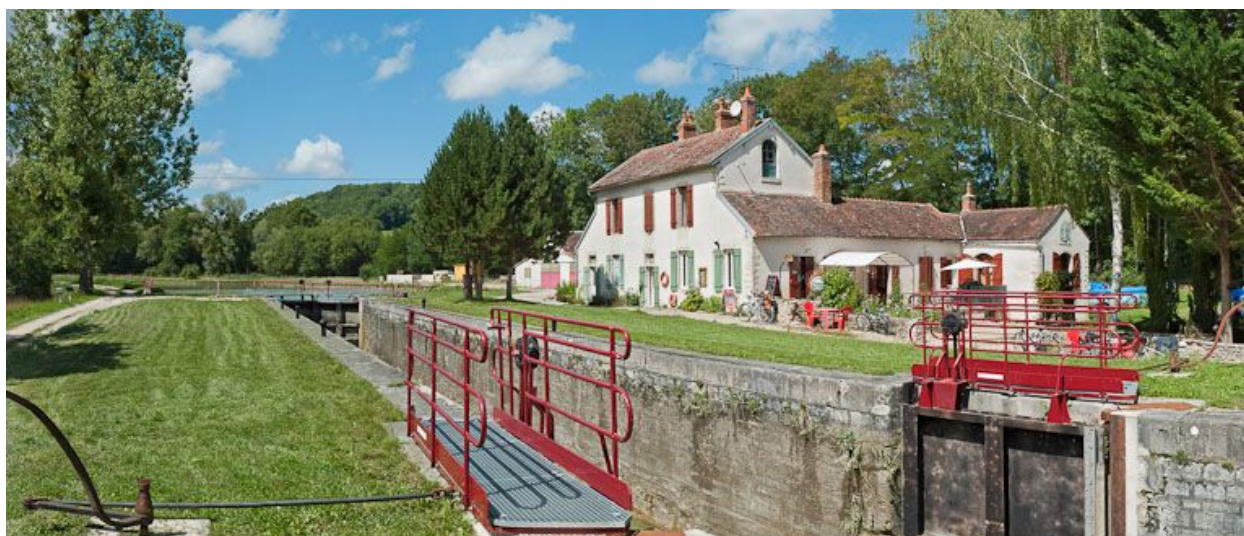
Vue d'ensemble du site d'écluse.
