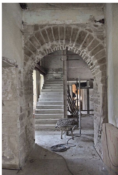
Couloir et escalier pendant les travaux. Phot. Thierry Kuntz IVR26_20098900141NUC2A
