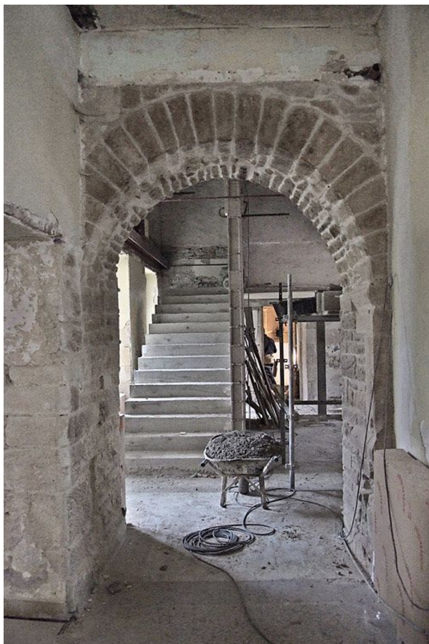
Couloir et escalier pendant les travaux.
