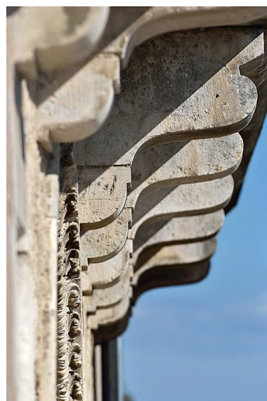
Consoles supportant le balcon de la façade rue du Château. Phot. Thierry Kuntz IVR26_20108900126NUC2A
