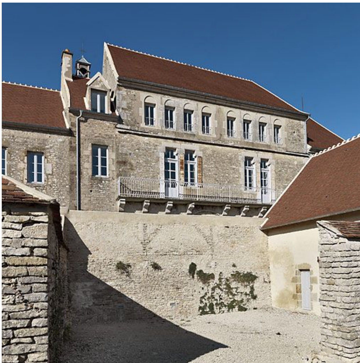
Façade postérieure du corps de bâtiment principal.
