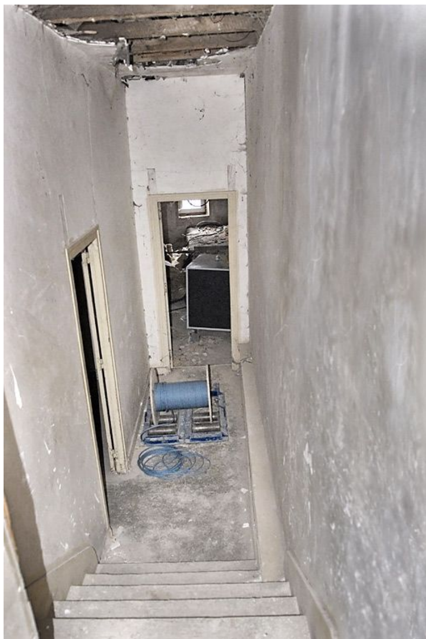
Couloir et escalier pendant les travaux.
