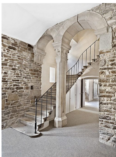
Escalier situé près de la chapelle. Phot. Thierry Kuntz IVR26_20108900131NUC4A
