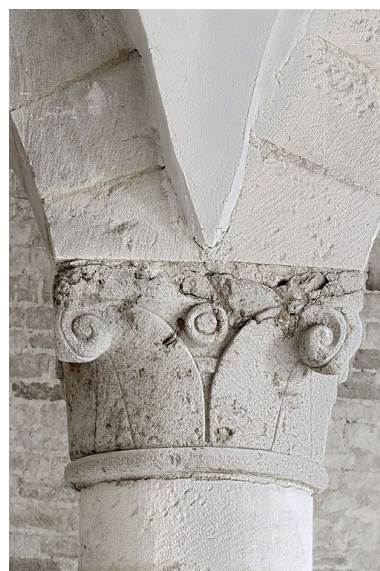
Salle voûtée, détail. Phot. Thierry Kuntz IVR26_20108900144NUC2A
