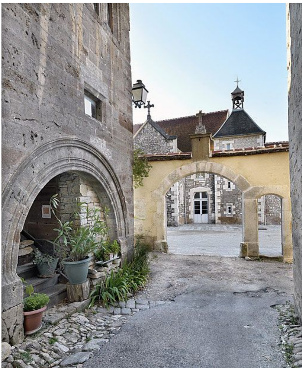
Vue d'ensemble depuis la rue du Couvent.
