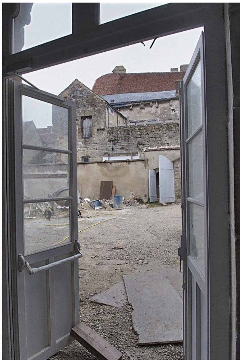
Vue de la cour pendant les travaux.
