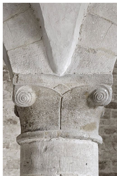
Salle voûtée, détail. Phot. Thierry Kuntz IVR26_20108900140NUC2A
