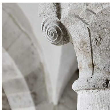
Salle voûtée, détail. Phot. Thierry Kuntz IVR26_20108900143NUC2A
