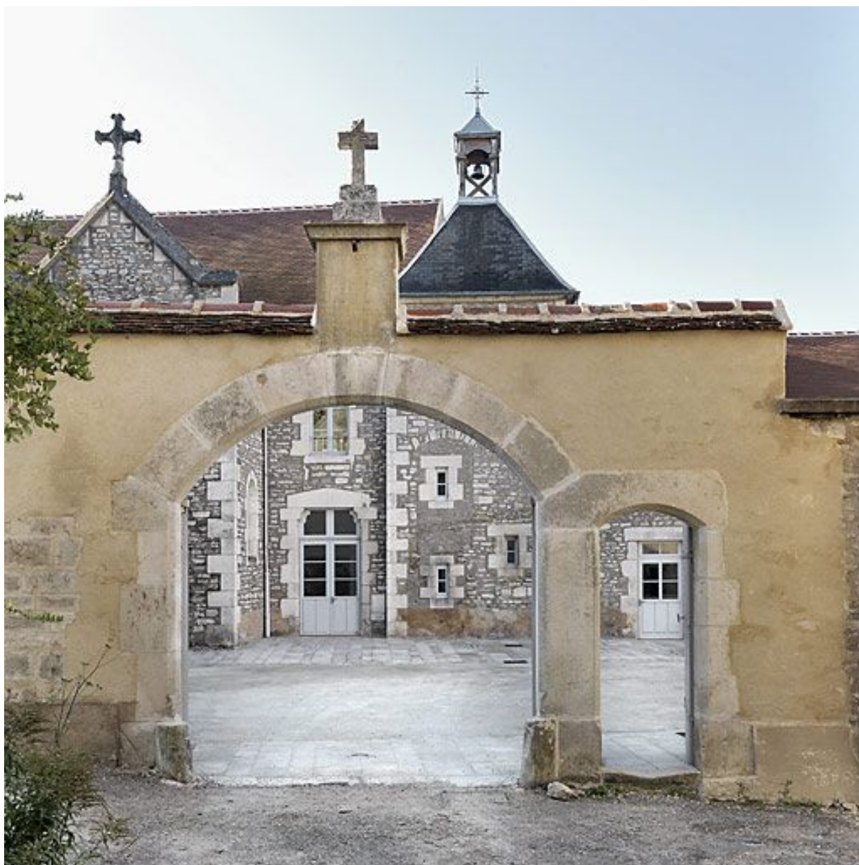
Vue d'ensemble depuis la rue du Couvent.
