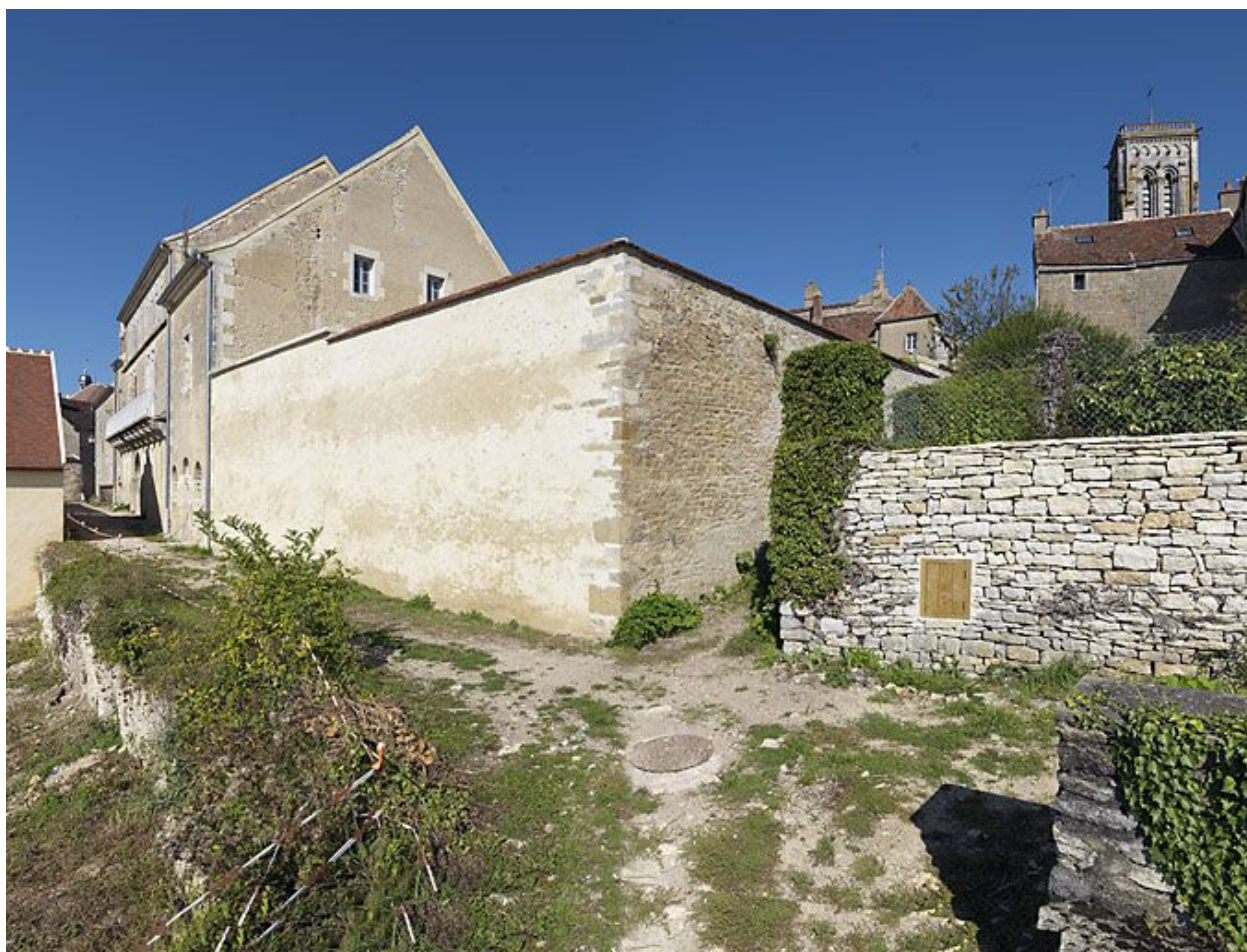
Vue d'ensemble prise du sud-est.
