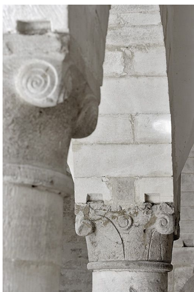
Salle voûtée, détail. Phot. Thierry Kuntz IVR26_20108900145NUC2A
