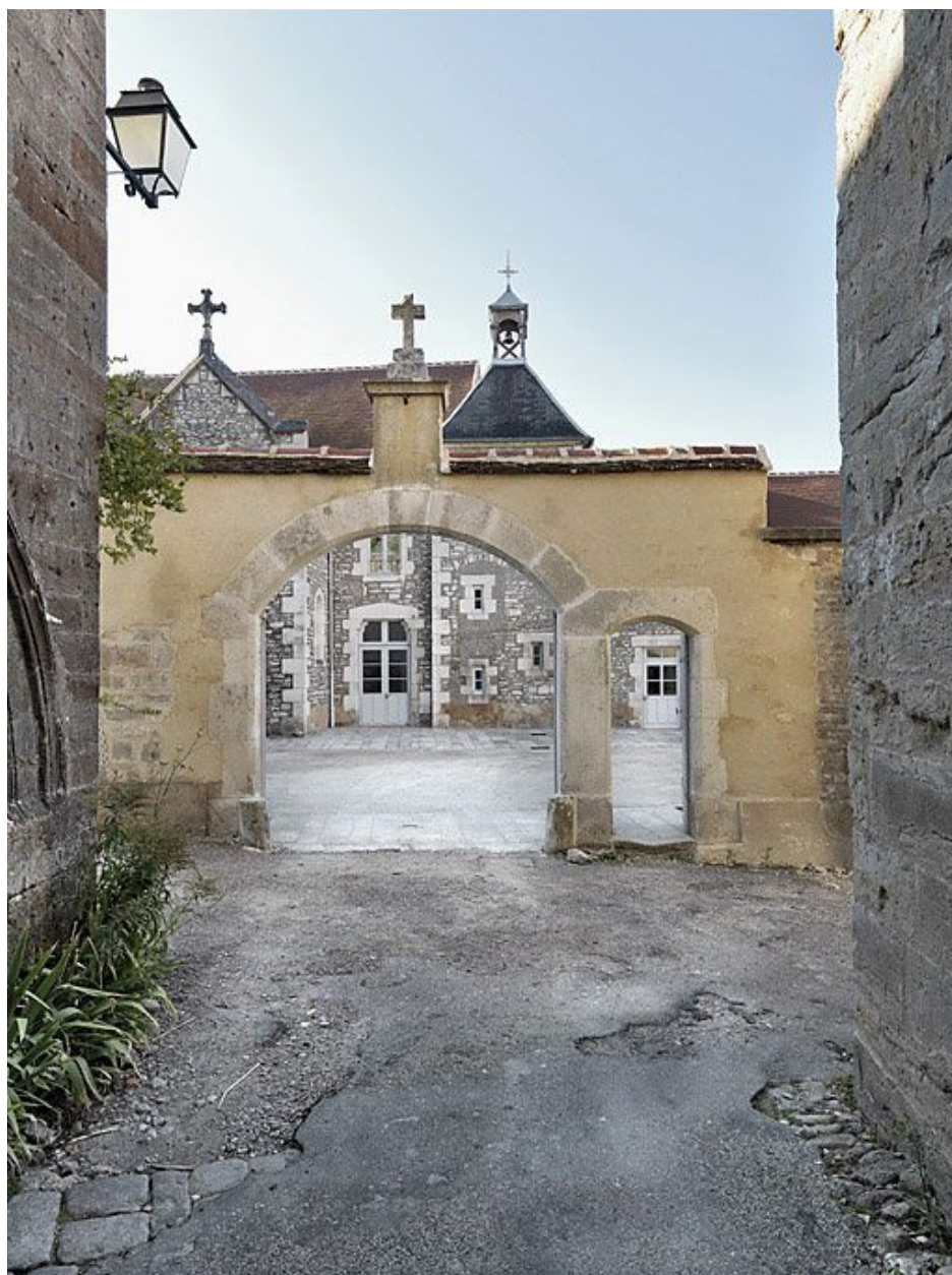
Vue d'ensemble depuis la rue du Couvent.
