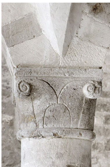
Salle voûtée, détail. Phot. Thierry Kuntz IVR26_20108900139NUC2A
