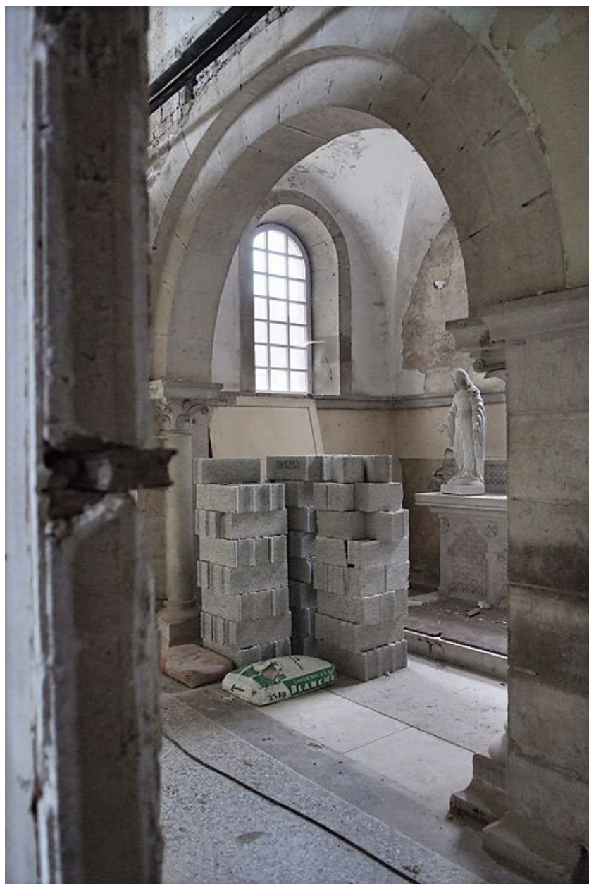
La chapelle pendant les travaux.
