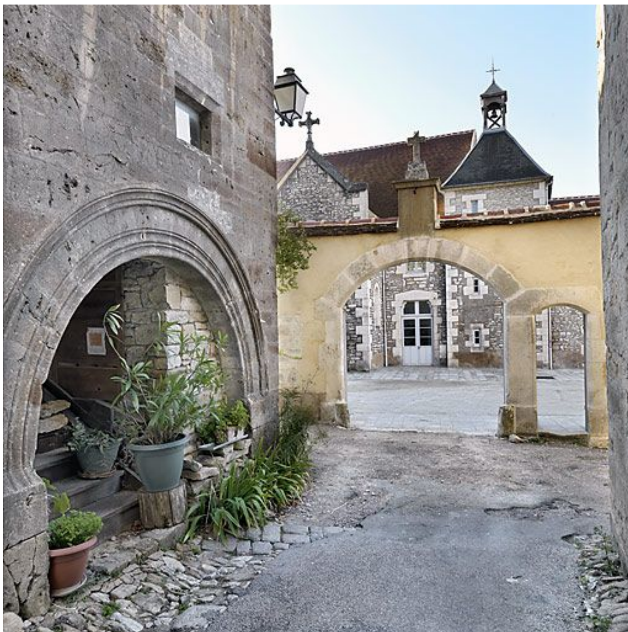
Vue d'ensemble depuis la rue du Couvent.
