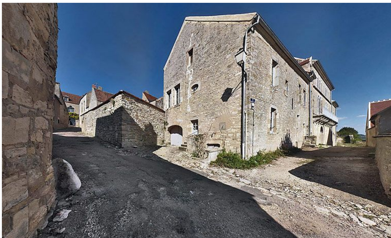
Vue d'ensemble des façades postérieures.
