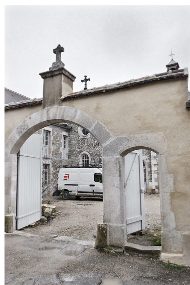
Vue d'ensemble avec le portail d'entrée. Phot. Thierry Kuntz IVR26_20098900147NUC2A
