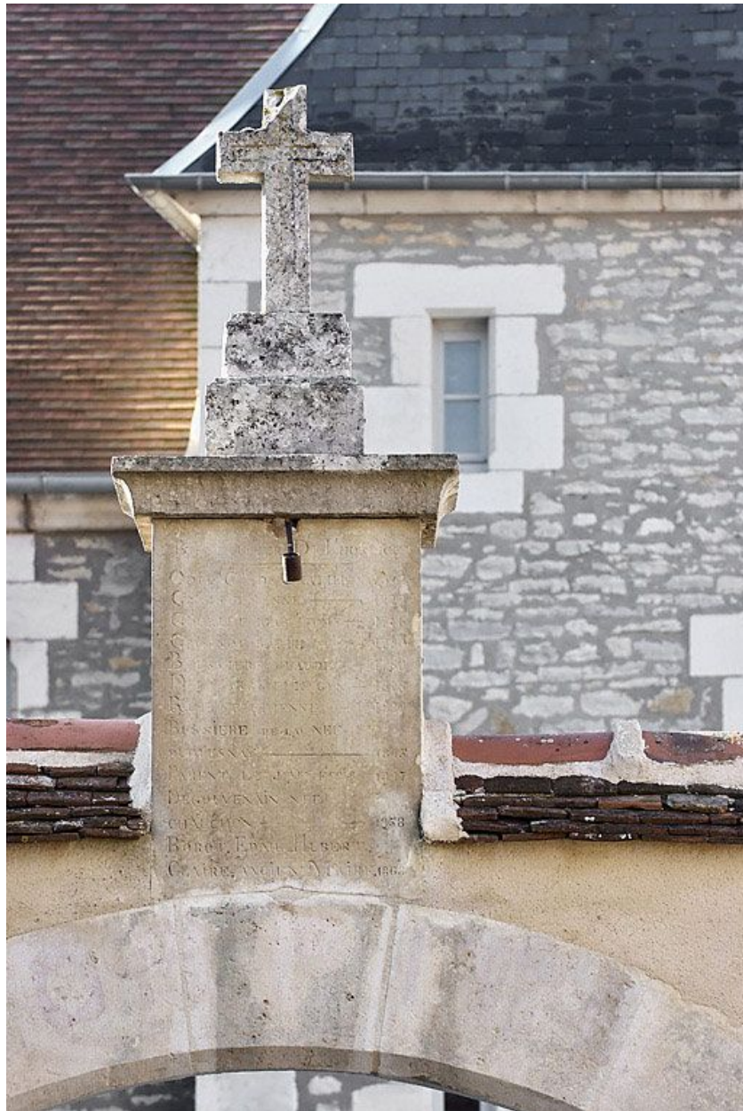
Détail de la croix surmontant le portail.
