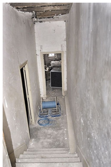
Couloir et escalier pendant les travaux. Phot. Thierry Kuntz IVR26_20098900144NUC2A
