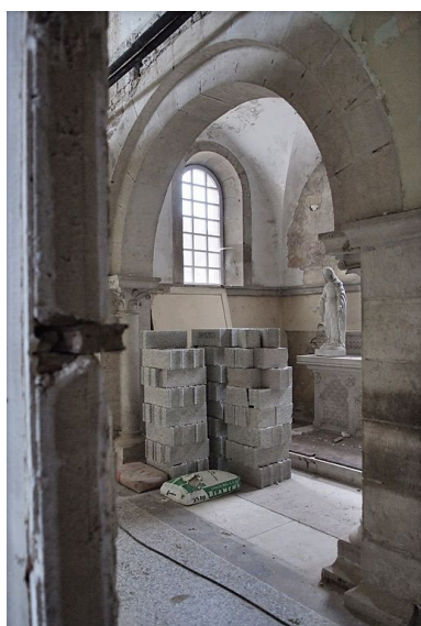
La chapelle pendant les travaux. Phot. Thierry Kuntz IVR26_20098900142NUC2A
