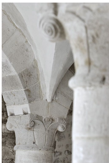
Salle voûtée, détail. Phot. Thierry Kuntz IVR26_20108900137NUC2A
