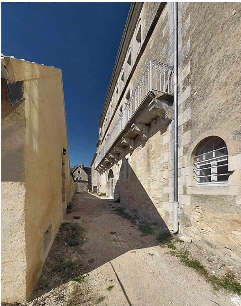
Elévations postérieures, rue du Château.
