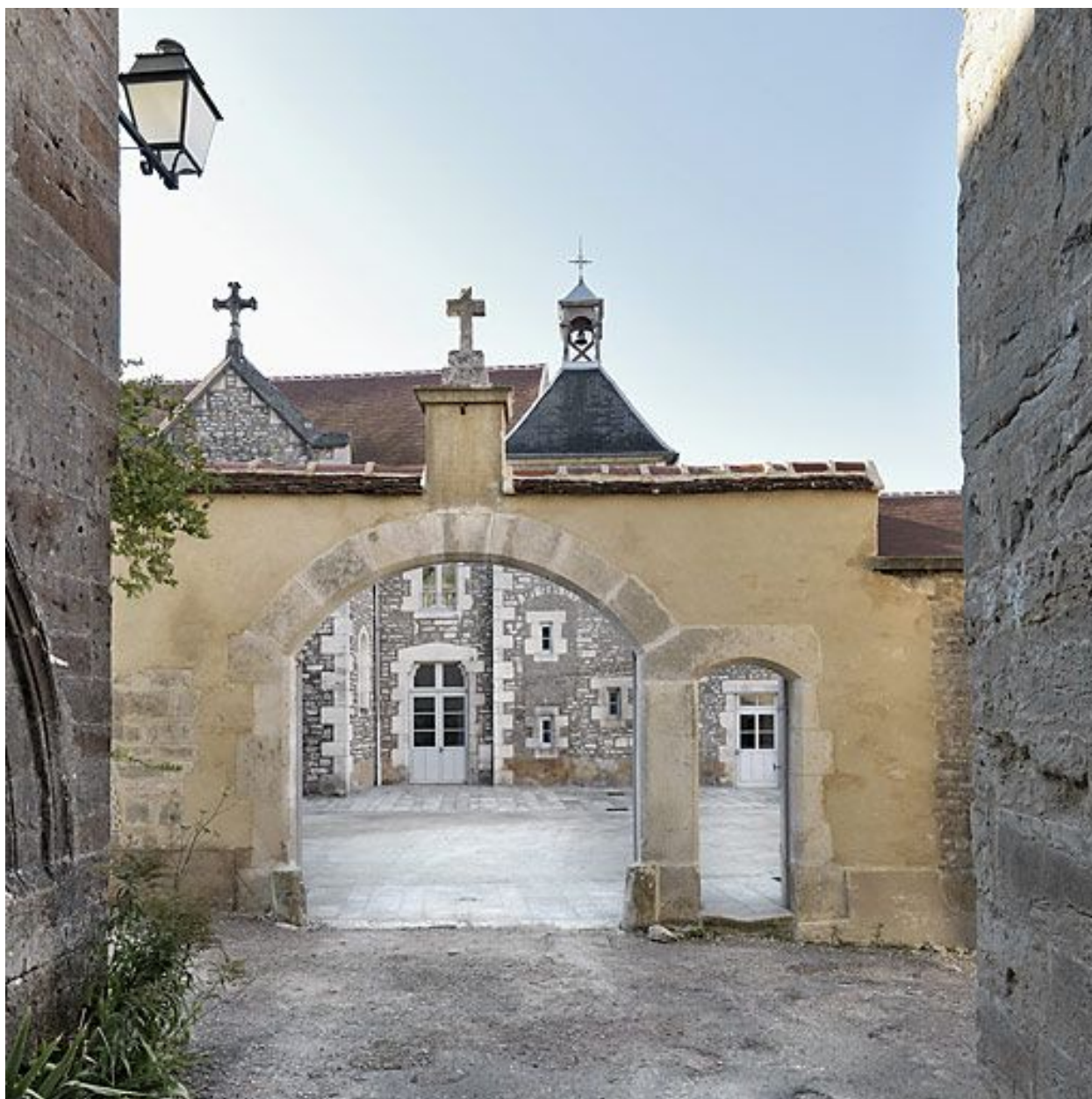
Vue d'ensemble depuis la rue du Couvent.
