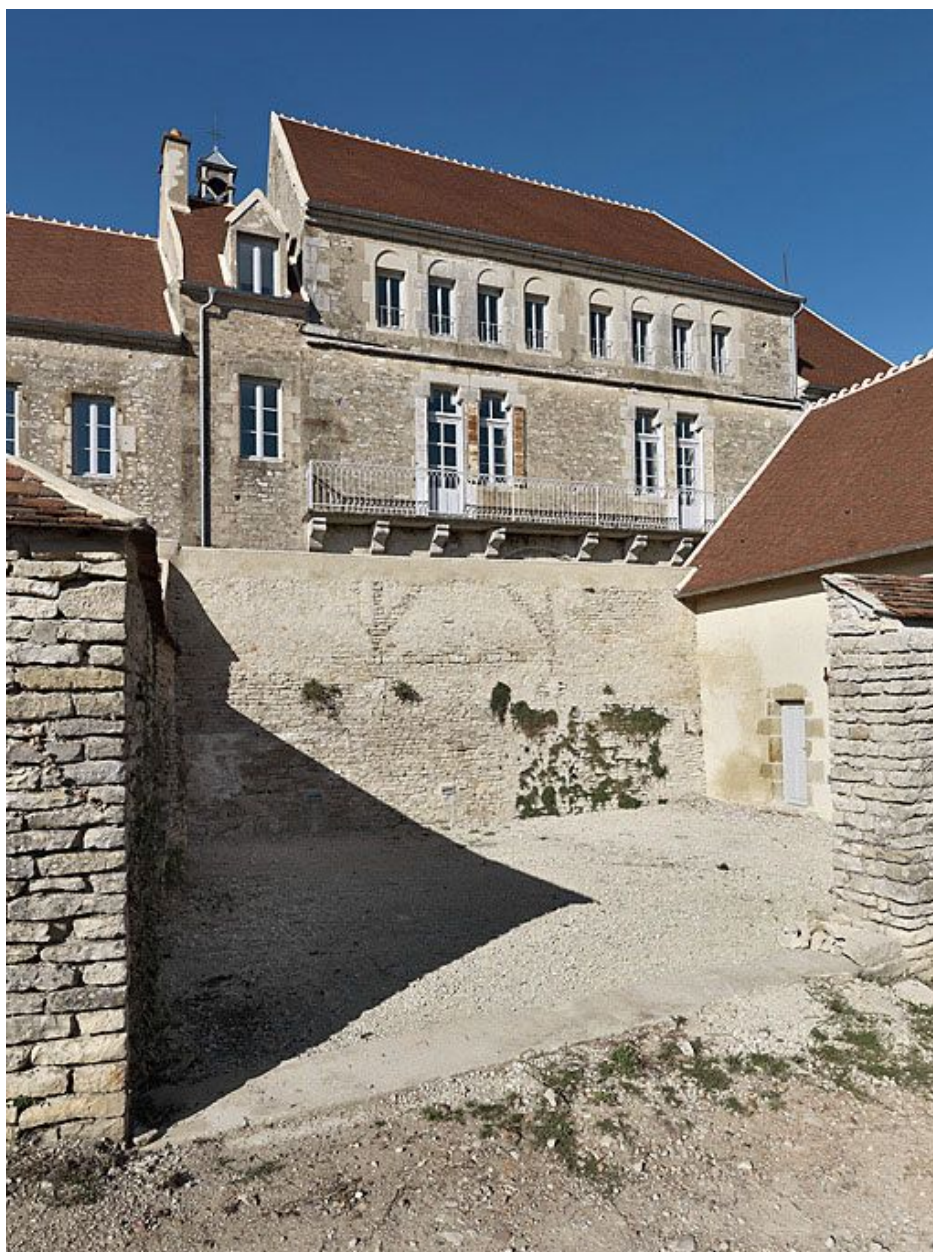
Façade postérieure du corps de bâtiment principal.
