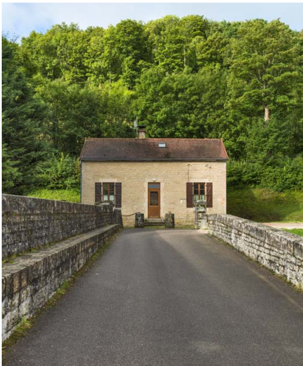
Vue rapprochée de la maison.
