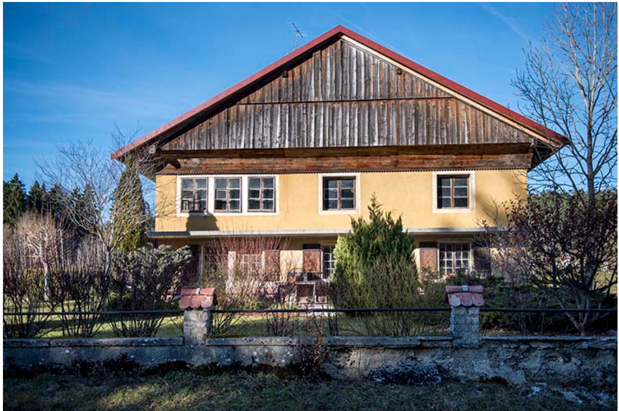
Façade latérale droite.
