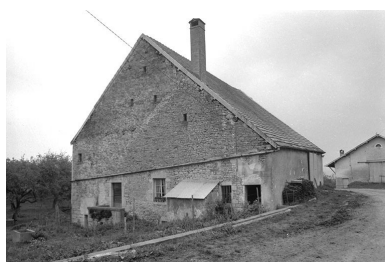
Ferme situé rue du Grand Courtil. Phot. Gilbert Poinot IVR43_19762500934Z
