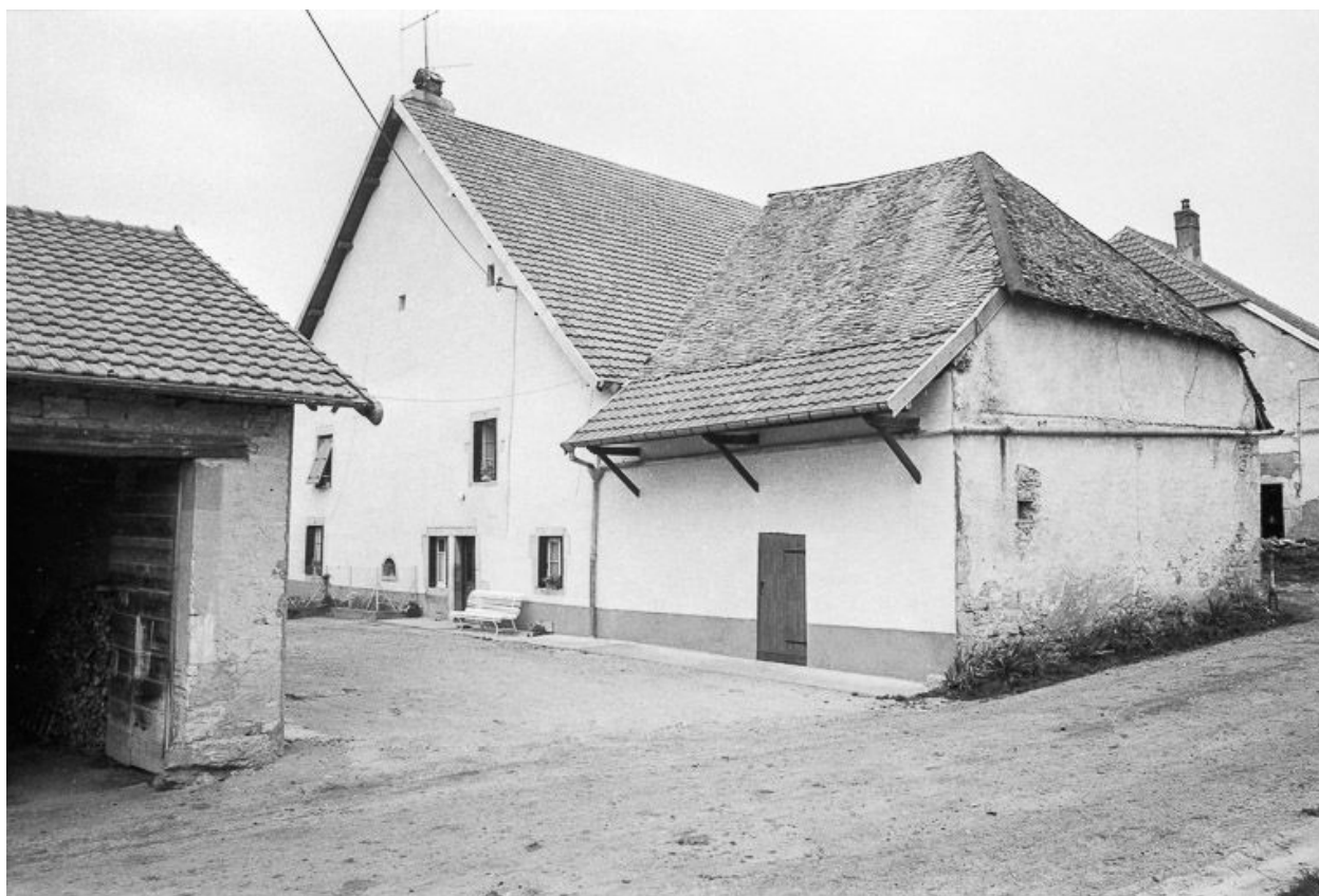
Ferme située rue du Grand Courtil.
