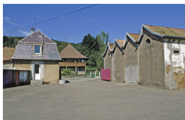
Conciergerie et murs-pignons d'un atelier de fabrication. Phot. Yves Sancey IVR43_19999000068ZA
