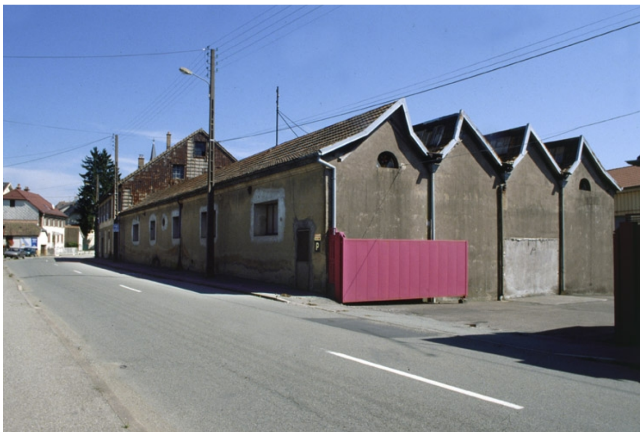
Atelier de fabrication longeant la rue d'Etueffont.
