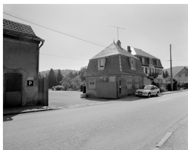
L'entrée depuis la rue d'Etueffont. Phot. Yves Sancey IVR43_19999000071X
