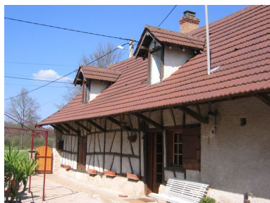
Vue d'ensemble de la façade.
