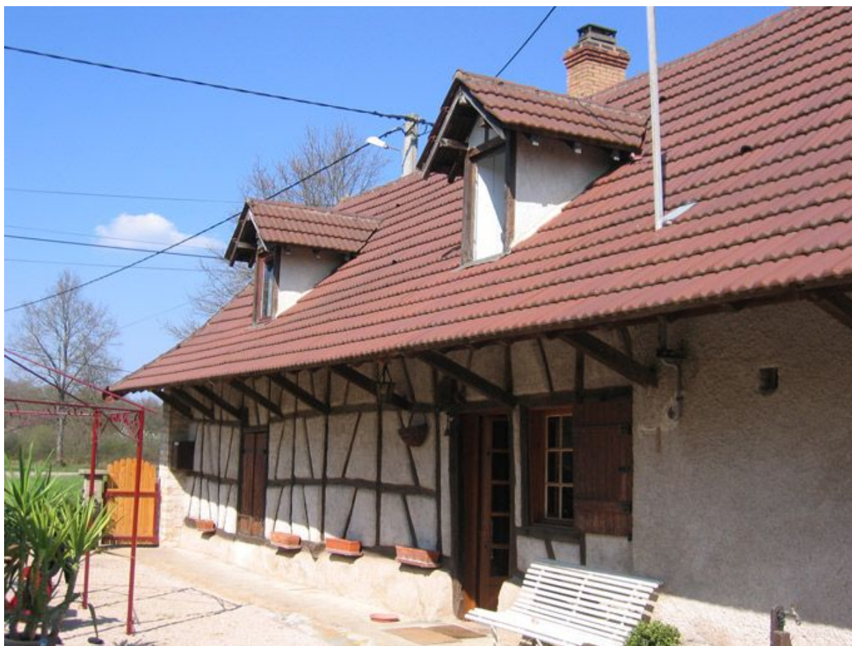
Vue d'ensemble de la façade.
