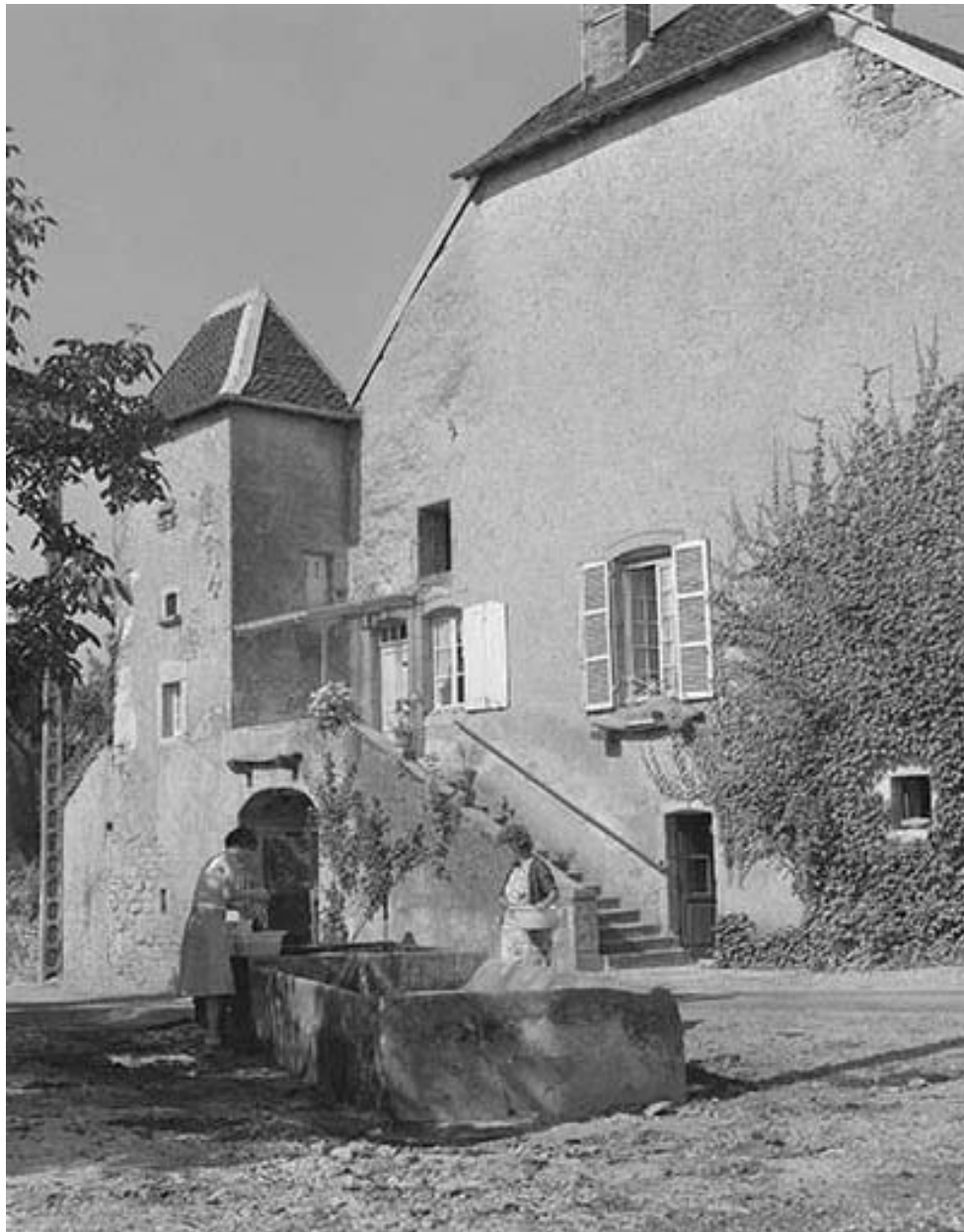
Elévation sur la rue : partie gauche.
