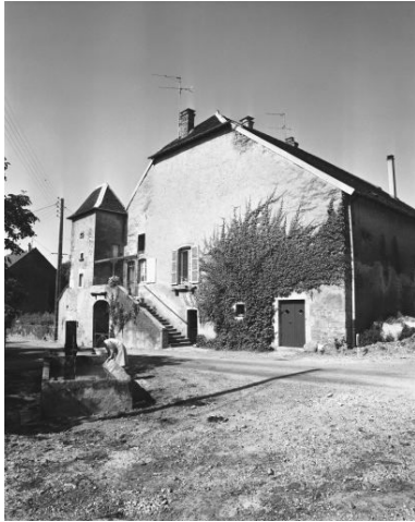
Elévation sur la rue. Phot. Dominique Dominguez IVR43_19803900038X
