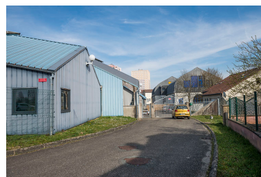
Vue de l'ouest, l'entrée sud- ouest, entre les ateliers et le logement de fonction. Phot. Mary Ruffinoni IVR43_20149000062NUC4A
