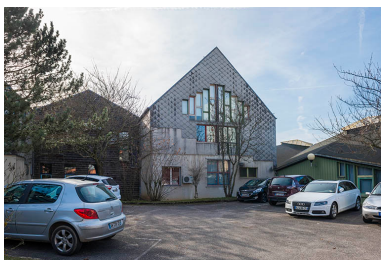
Façades postérieures est des externats du nord. Phot. Mary Ruffinoni IVR43_20149000066NUC4A
