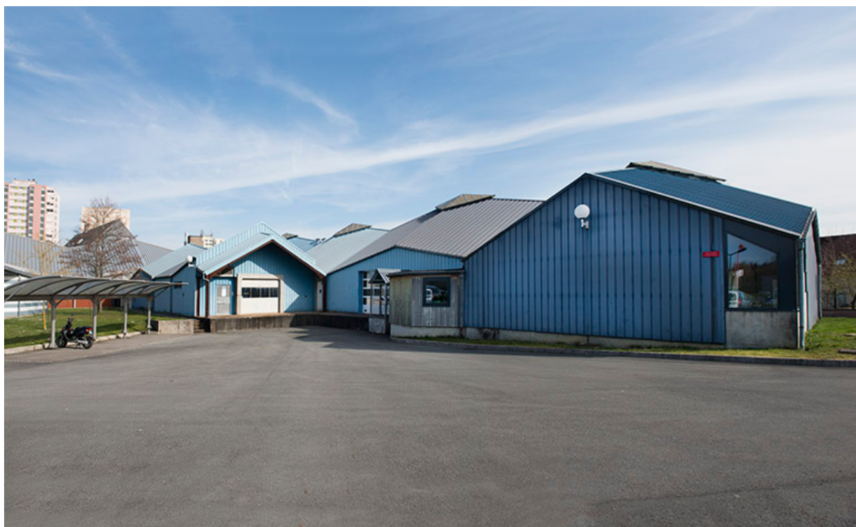
Façades postérieures ouest des ateliers de mécanique.
