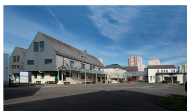
La place vue de l'ouest. Phot. Mary Ruffinoni IVR43_20149000073NUC4A
