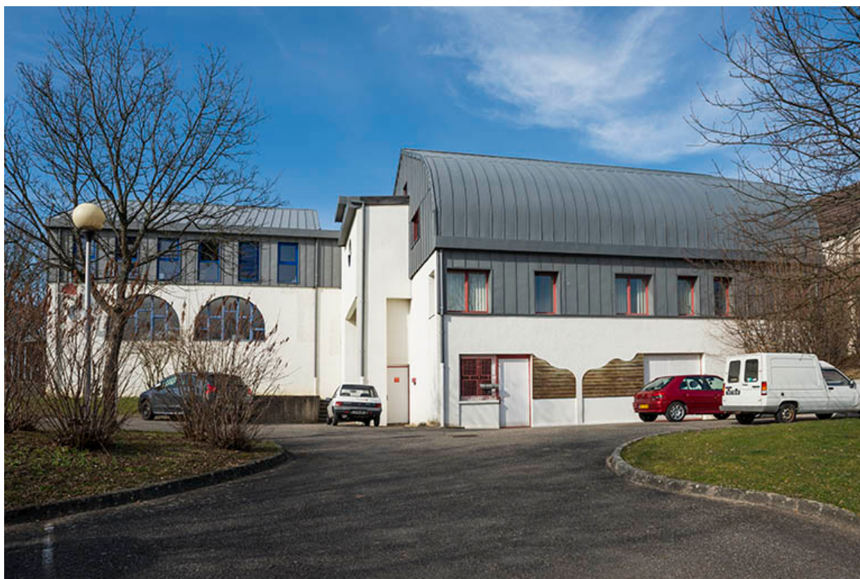
Façades sud de l'administration.
