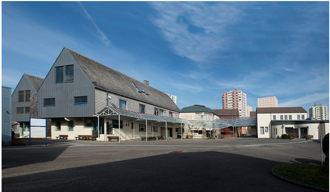
La place vue de l'ouest.
