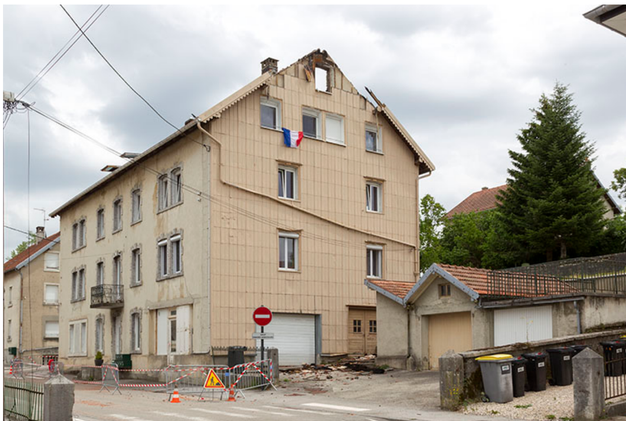
Façades antérieure et latérale droite.
