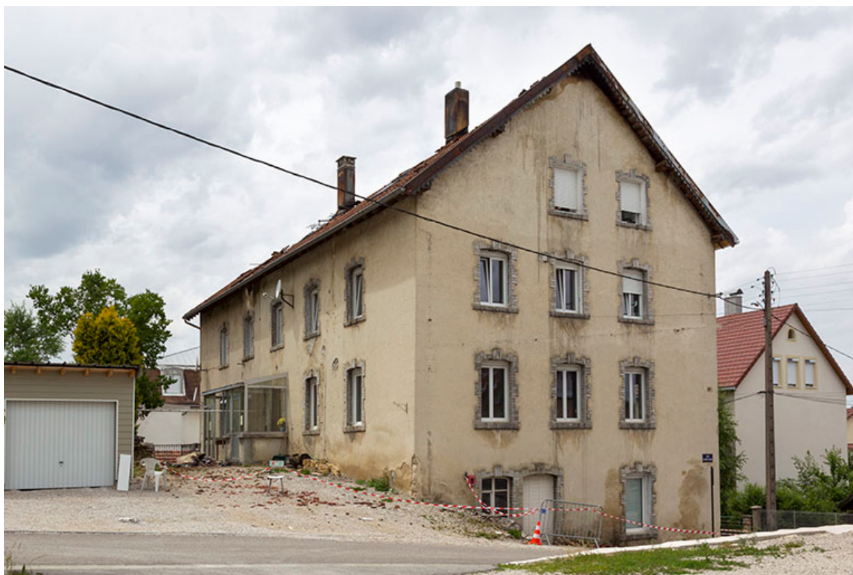
Façades postérieure et latérale gauche.
