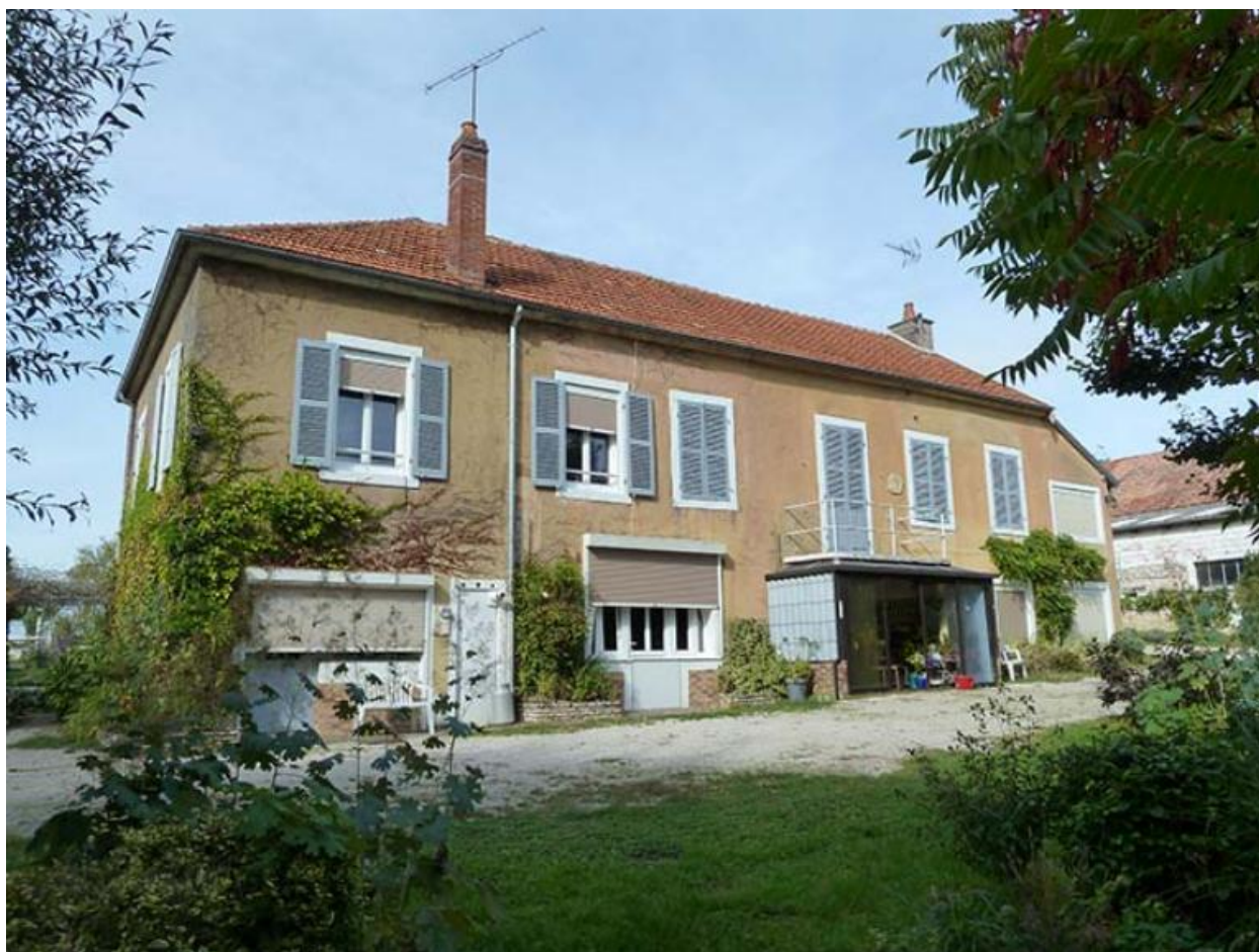
Vue sud-ouest du logis
