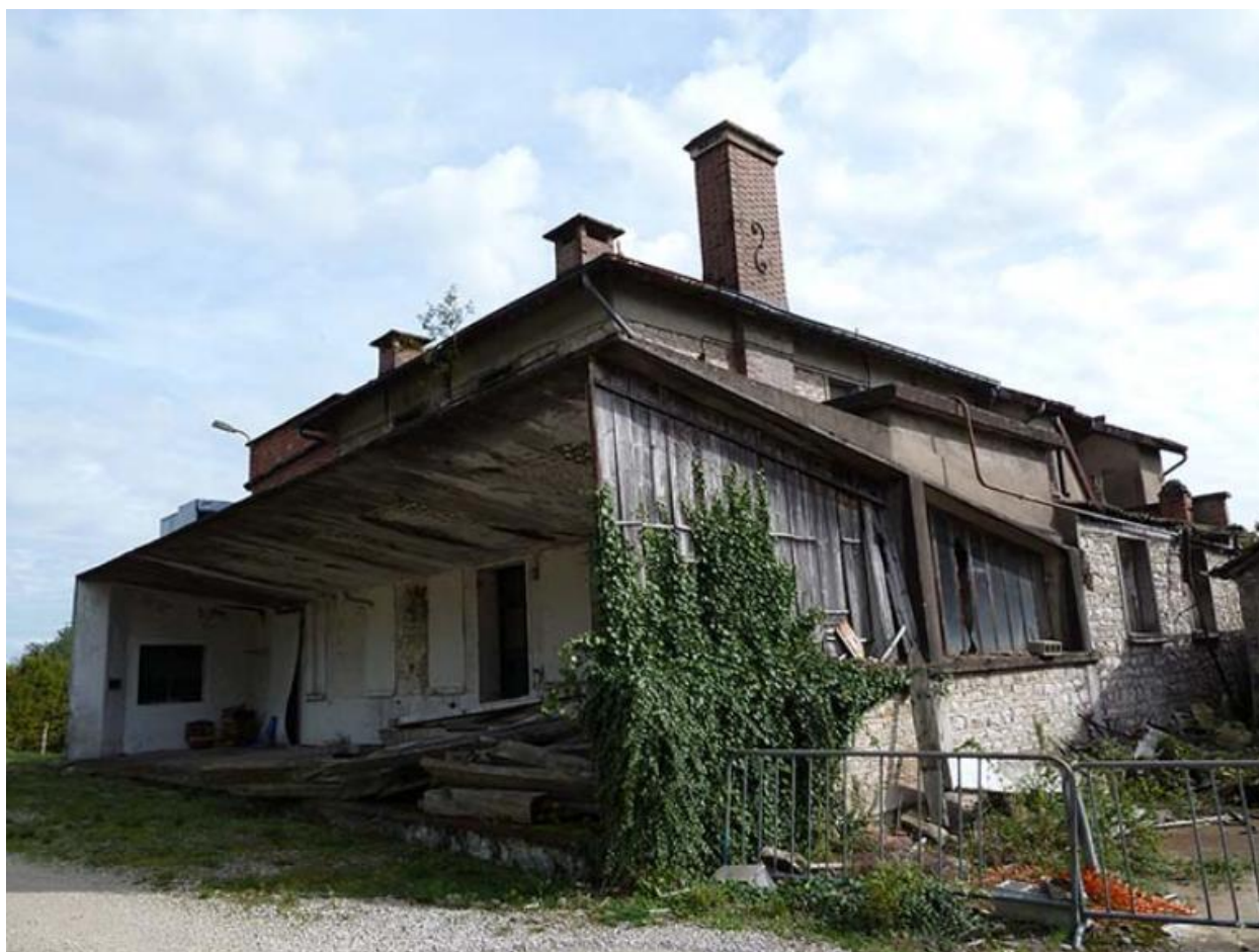
Vue générale nord ouest de la laiterie
