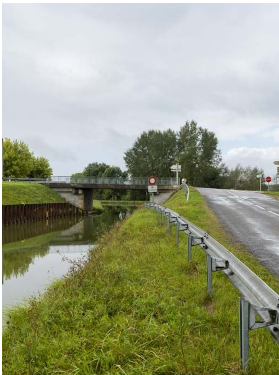
Vue d'ensemble du pont.
