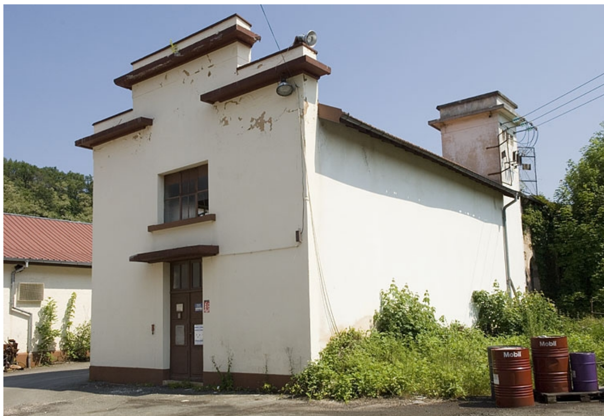
Ancien bâtiment d'eau et transformateur.
