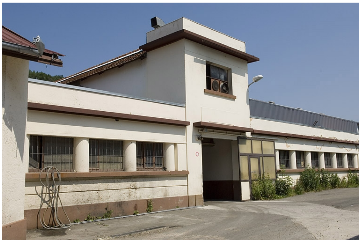
Façade antérieure de l'atelier de fabrication.
