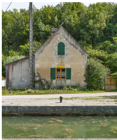
Vue de la maison éclusière.
