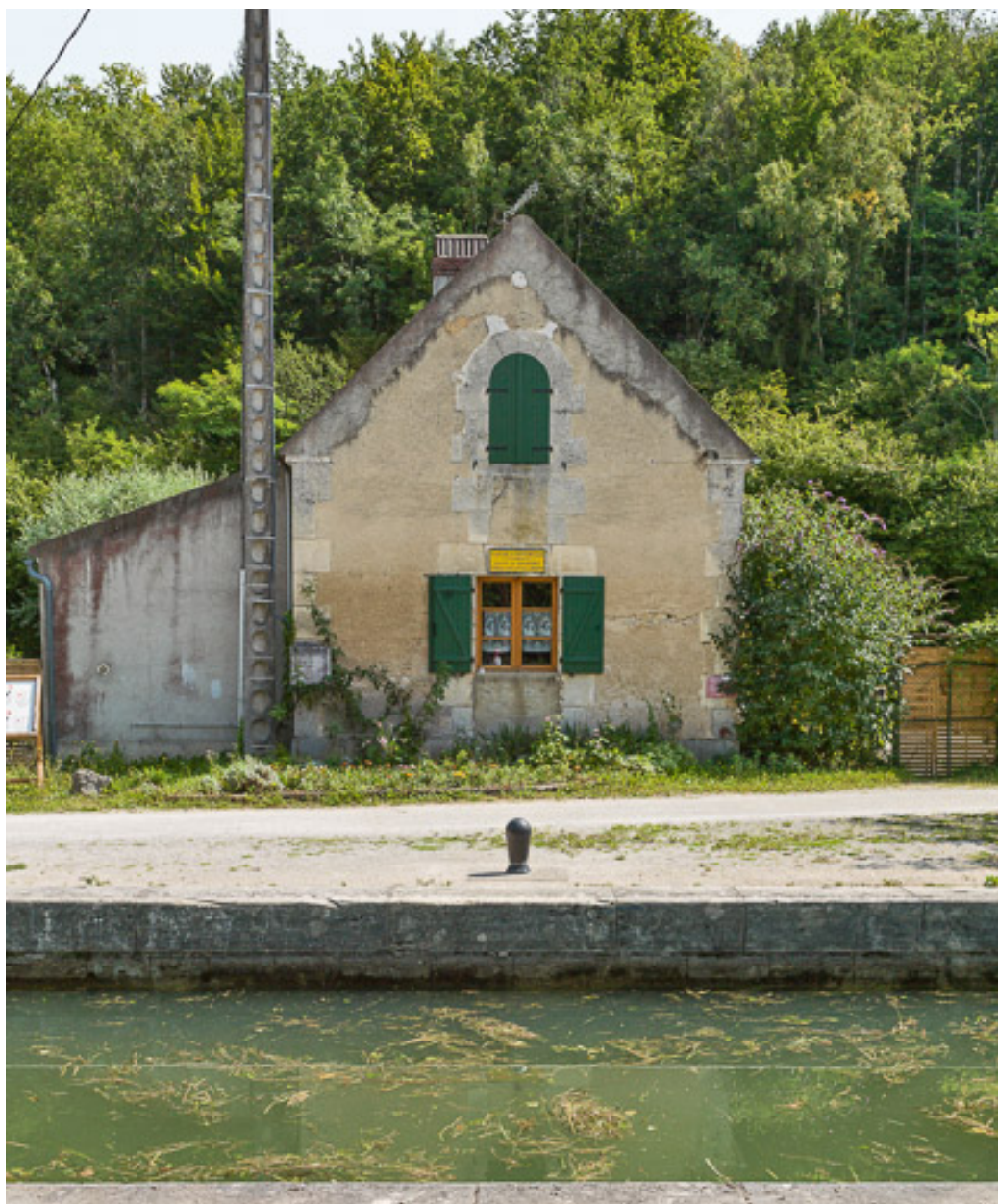
Vue de la maison éclusière.
