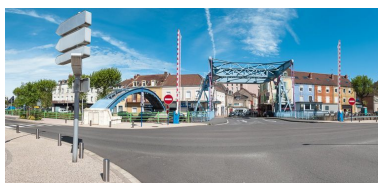
Vue d'ensemble du pont-levis routier isolé de Montceau. Phot. Pierre-Marie Barbe-Richaud IVR26_20137100428NUC2AQ
