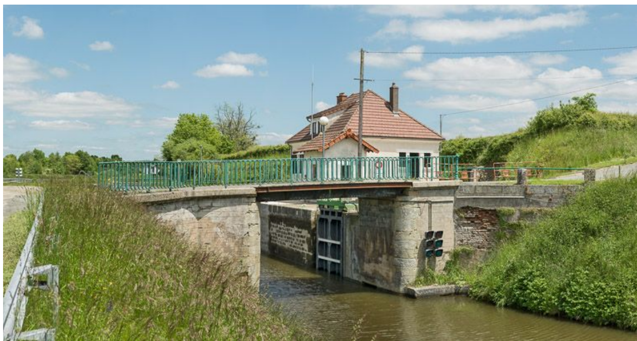
Vue d'aval du pont de Parisenot ou pont de Parizenot à Saint-Eusèbe.
