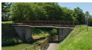
Le pont routier isolé de Paradis à Vitry-en-Charollais, vu d'amont. Phot. Pierre-Marie Barbe-Richaud IVR26_20137100539NUC4AQ
