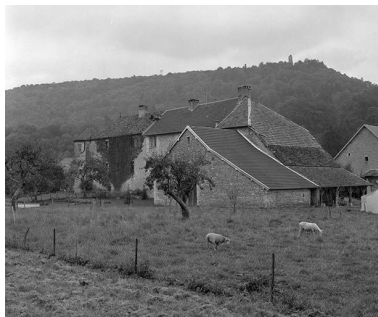
Façade postérieure. Phot. Yves Sancey IVR43_19802501155X
