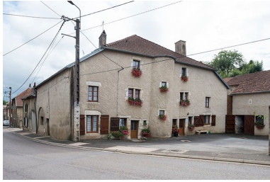
Vue d'ensemble. Phot. Jérôme Mongreville IVR43_20177001114NUC4A
