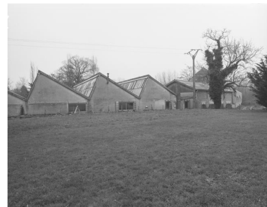
Sheds de l'atelier de fabrication et vestiaire. Phot. Jérôme Mongreville IVR43_19963901905X
