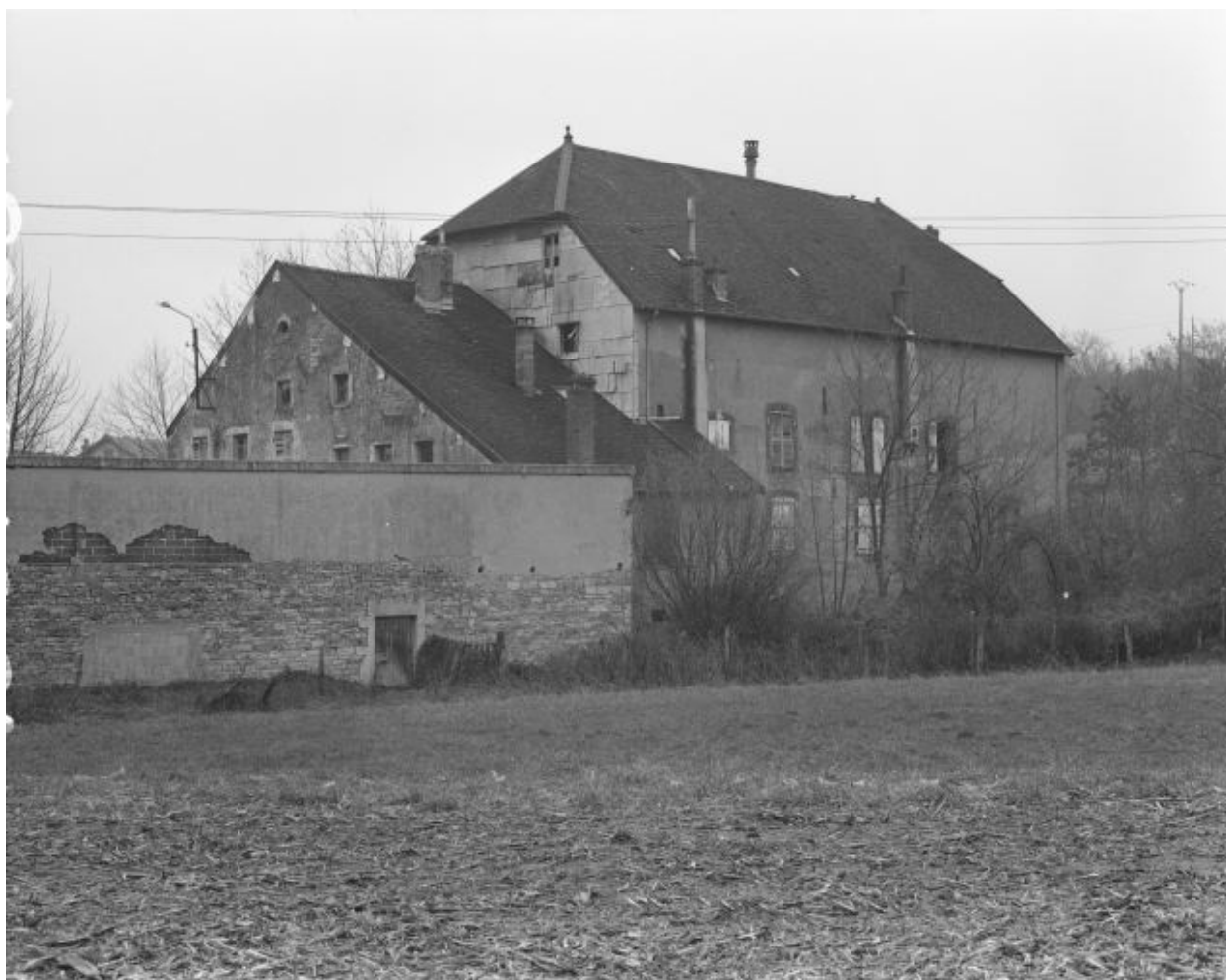
Vue du moulin depuis le sud-ouest.
