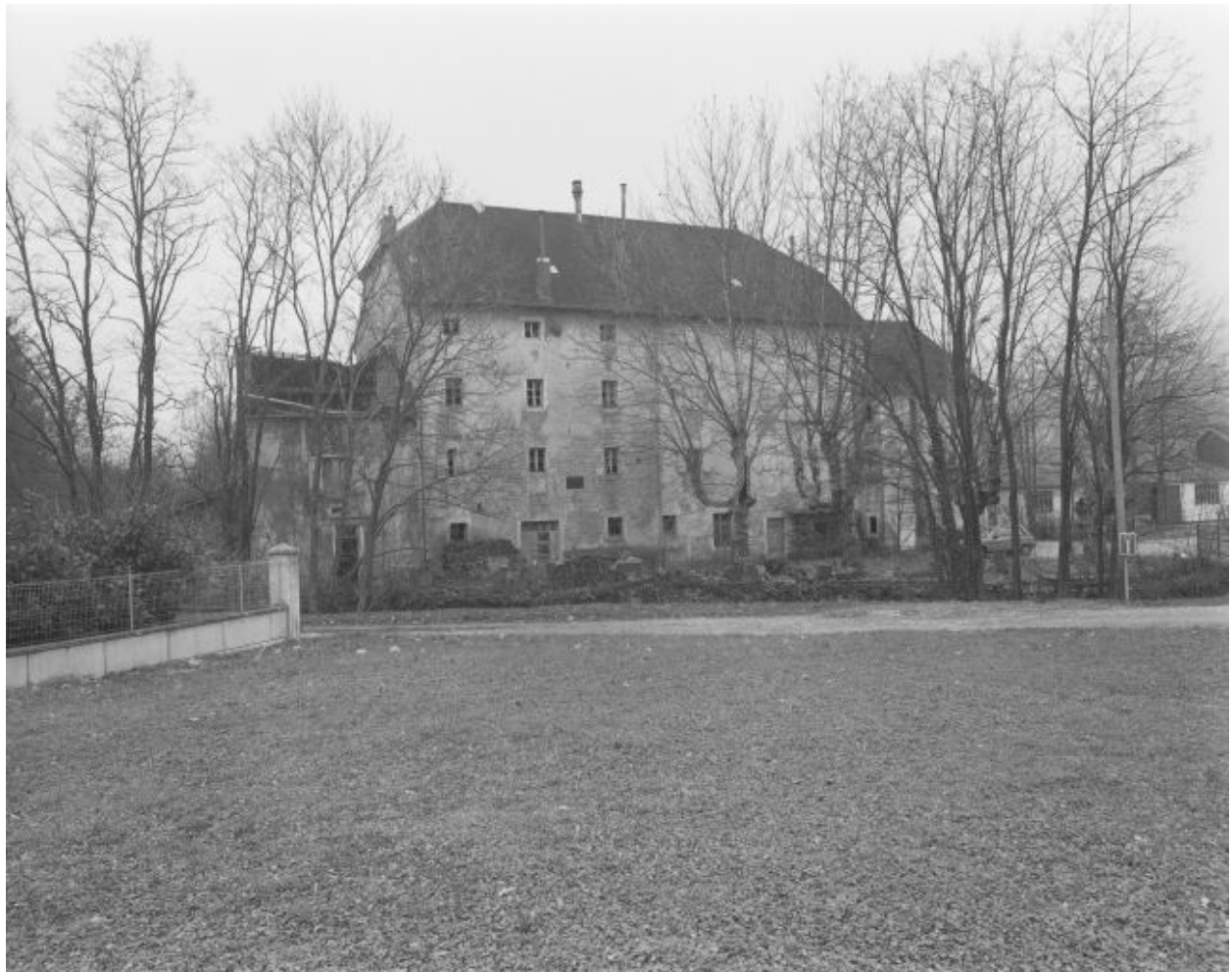
Façade postérieure du moulin.
