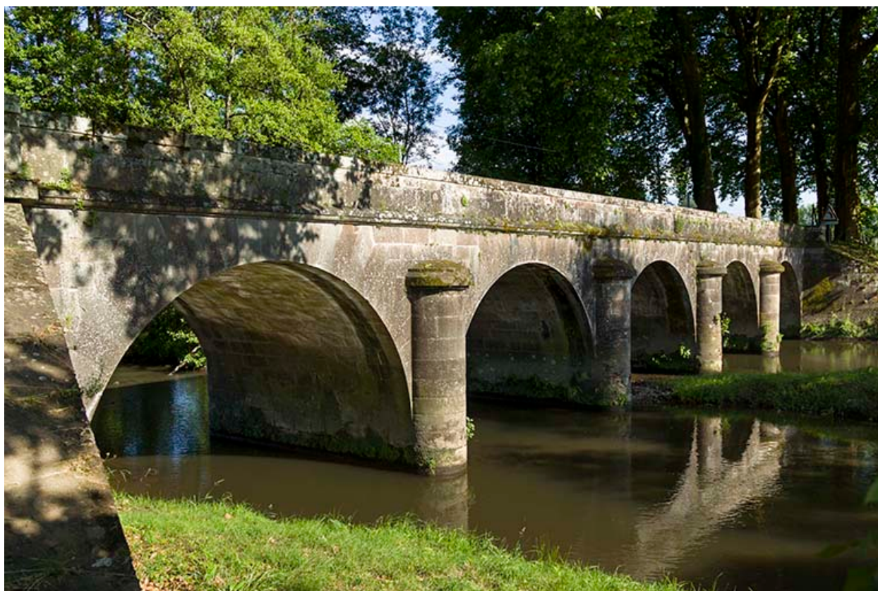
Vue du pont en aval.
