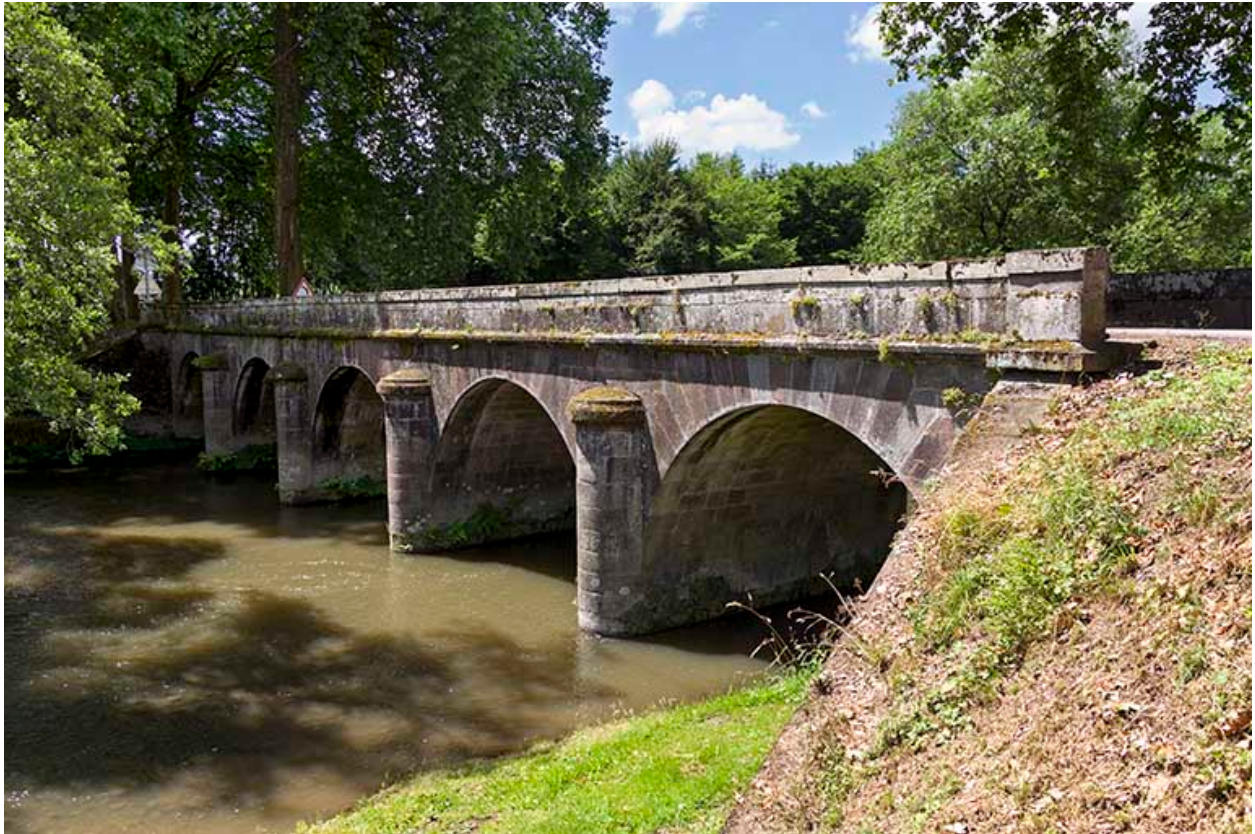
Vue du pont en amont.
