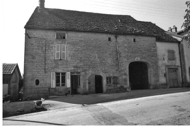
Façade antérieure vue de face en 1974. Phot. F. Pernin IVR43_19743900216Z
