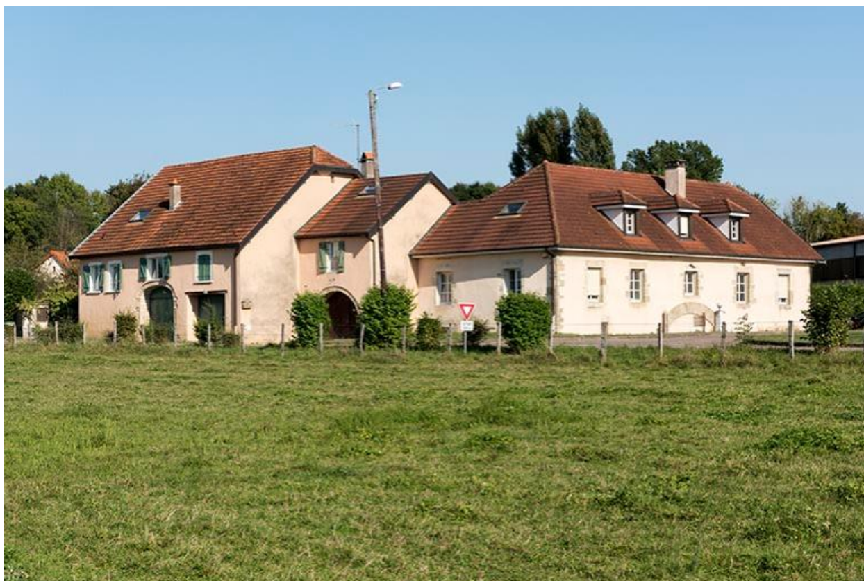
Ancien moulin aujourd'hui entreprise De Trevillers
