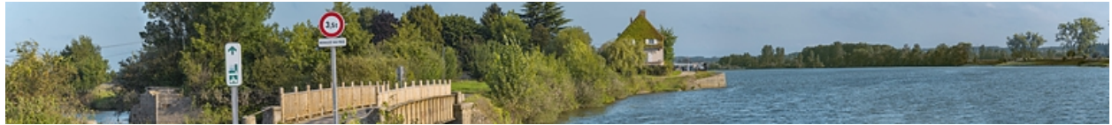
Pont et port de Grosne, rive droite.
