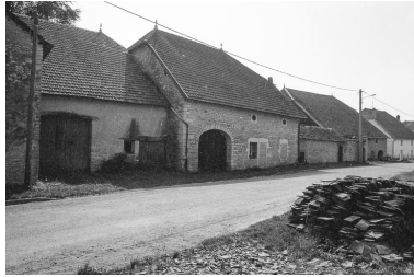
Vue d'ensemble des communs, trois quarts gauche. Phot. Bernard Lardière IVR43_19797000321Z
