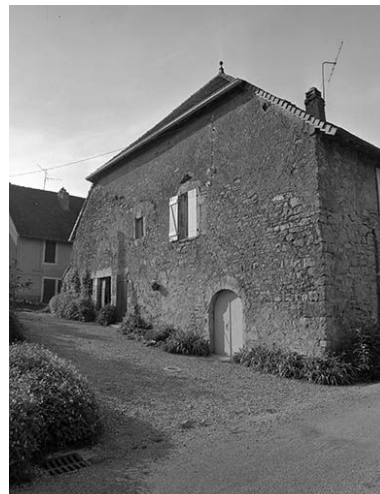
Façade latérale gauche. Phot. Dominique Dominguez IVR43_19803900247X
