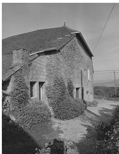
Façade latérale gauche. Phot. Dominique Dominguez IVR43_19803900017X
