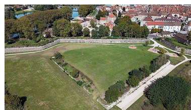
Vue aérienne de la demi-lune. Phot. Sébastien Bardou IVR26_20232100440NUC2A
