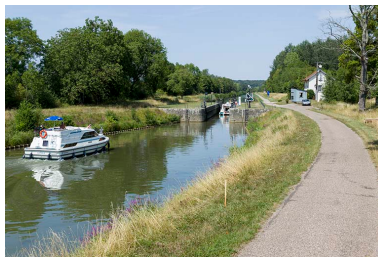
Vue amont du site d'écluse. Phot. Sonia Dourlot IVR43_20157000854NUC4A
