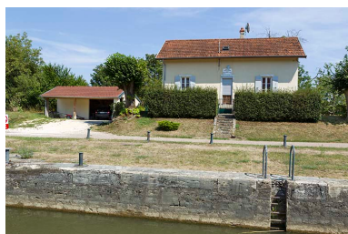
la maison d'éclusier. Phot. Sonia Dourlot IVR43_20157000855NUC4A
