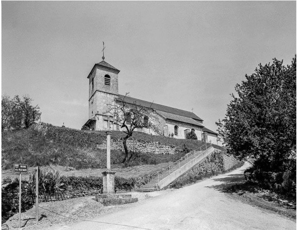
Eglise paroissiale Saint-Gengoul.
