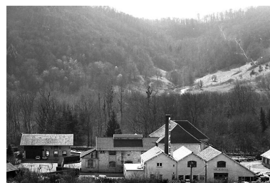
Moulin, distillerie Bailly, brosserie Legardeur, actuellement garage de réparation automobile Phot. Jérôme Mongreville IVR43_20002500021X
