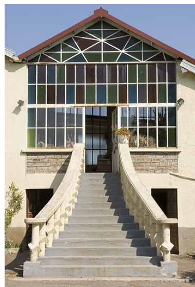
Entrée des bureaux. Phot. Jérôme Mongreville IVR43_20097000827NUC2A
