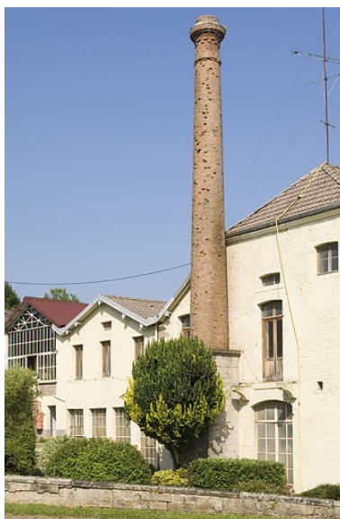
Façade est des ateliers et cheminée. Phot. Jérôme Mongreville IVR43_20097000826NUC2A
