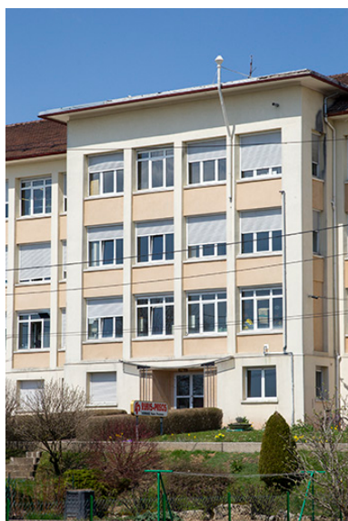
Avant-corps central de la façade antérieure.
