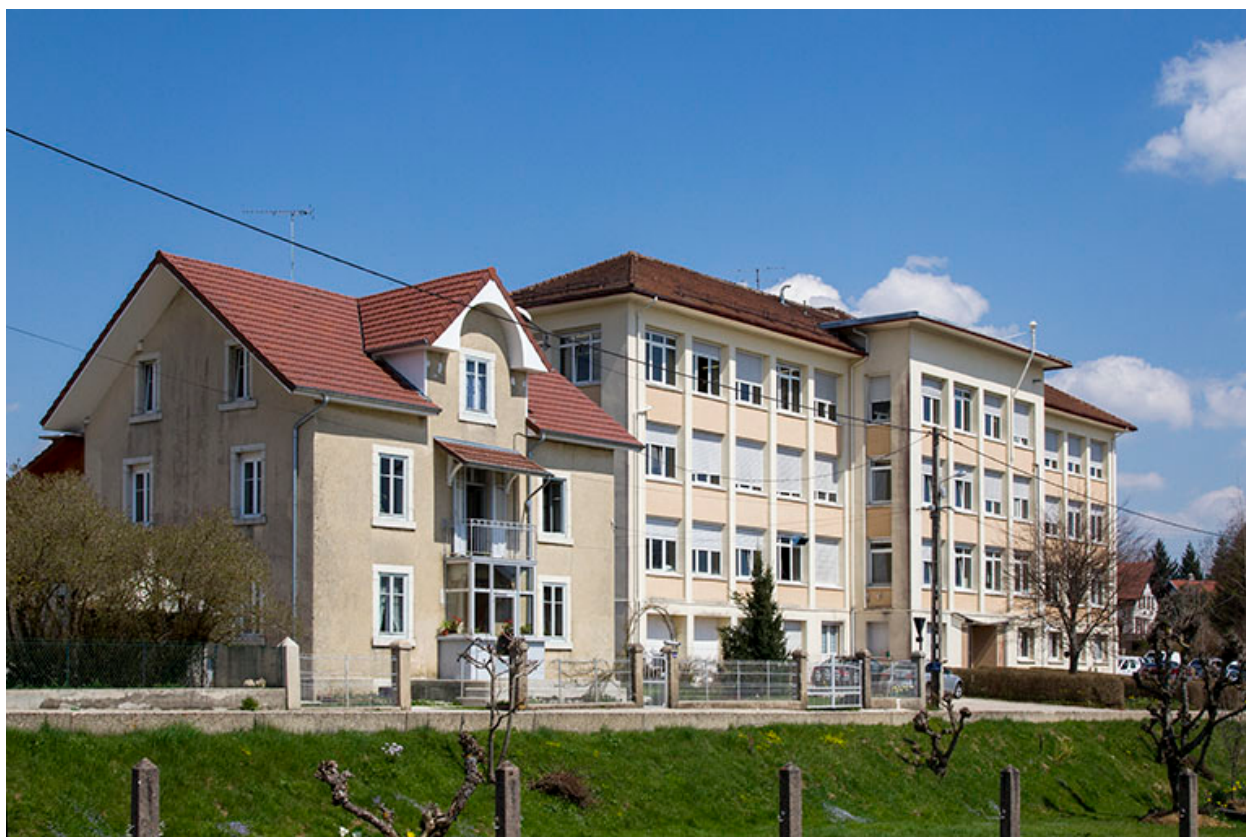
Façade antérieure, vue en enfilade depuis l'ouest.
