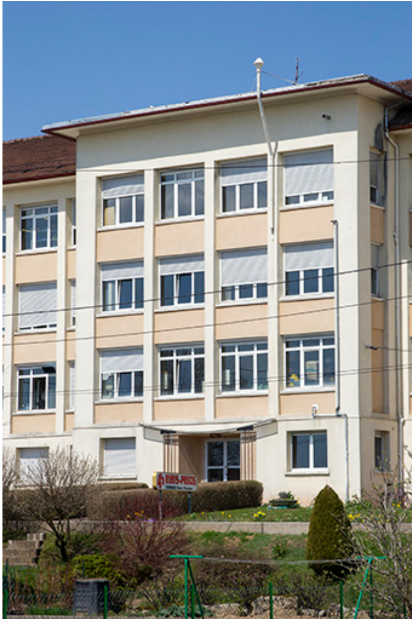
Avant-corps central de la façade antérieure.
