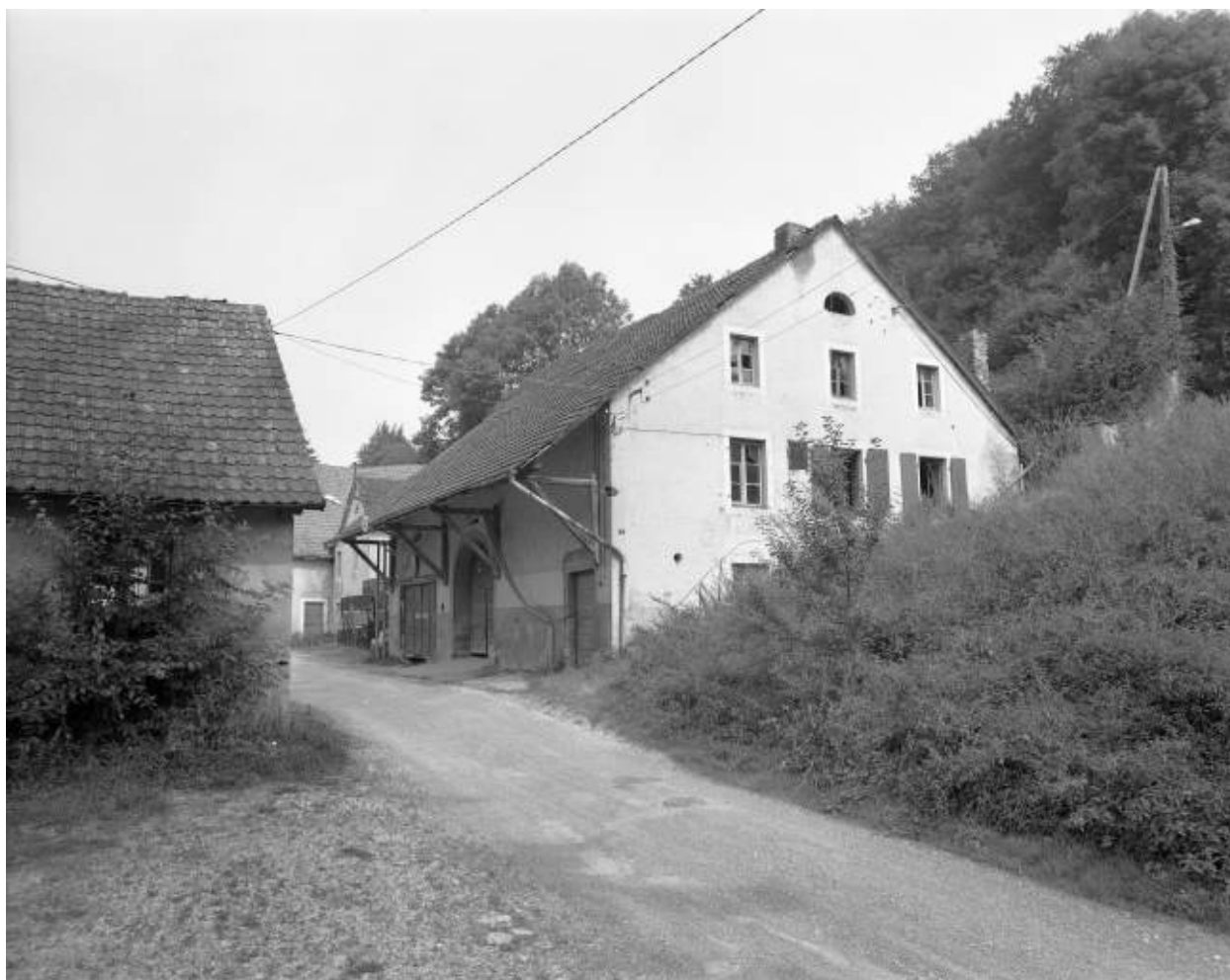
Bâtiment agricole en 1981.
