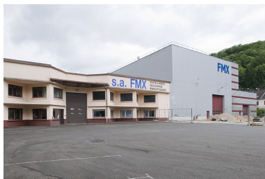
Façade nord des ateliers de fabrication.
