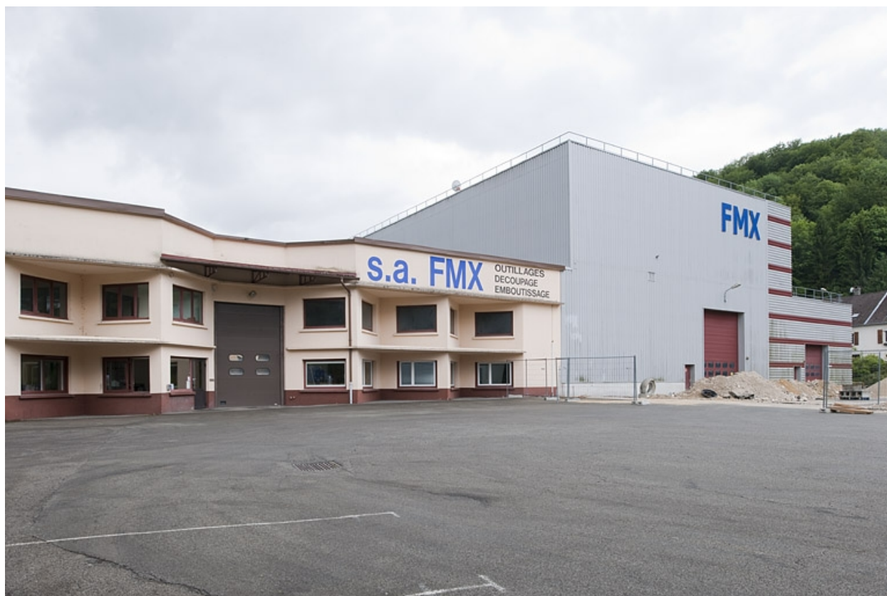
Façade nord des ateliers de fabrication.
