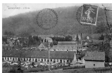
Meslières - L'usine. Carte postale, s.n., s.d. [fin 19e ou début 20e siècle]. Phot. Raphaël Favereaux, Autr. IVR43_20122501598NUC2
