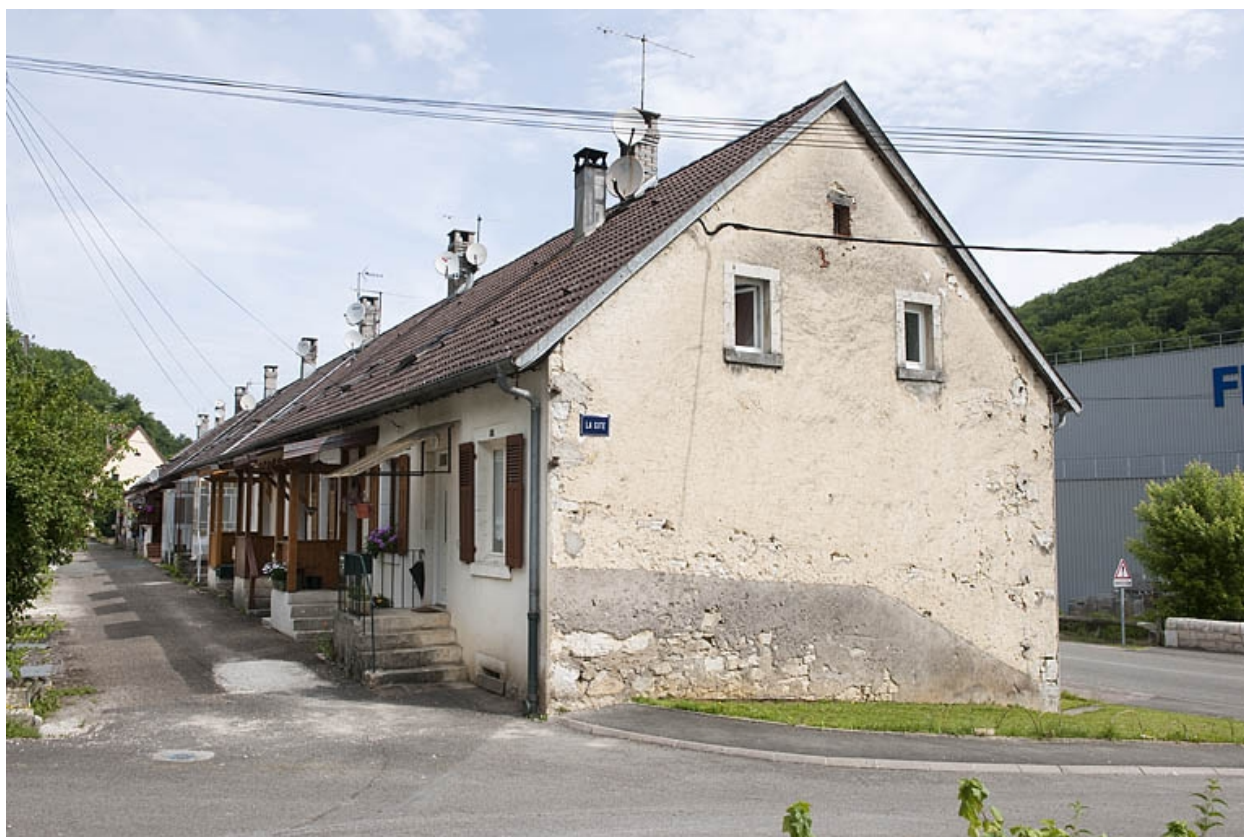
Logement d'ouvriers. Vue de trois quarts.
