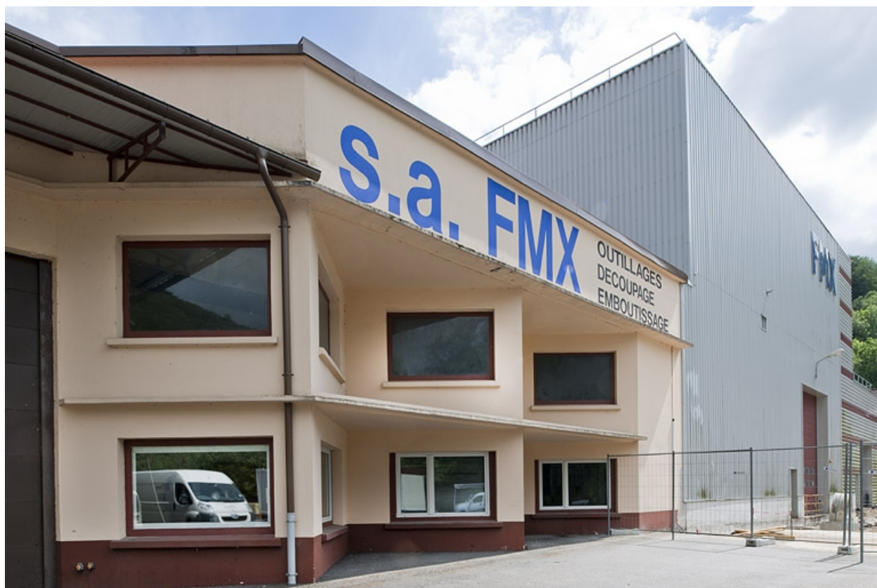
Façade nord : le nouvel atelier des presses.
