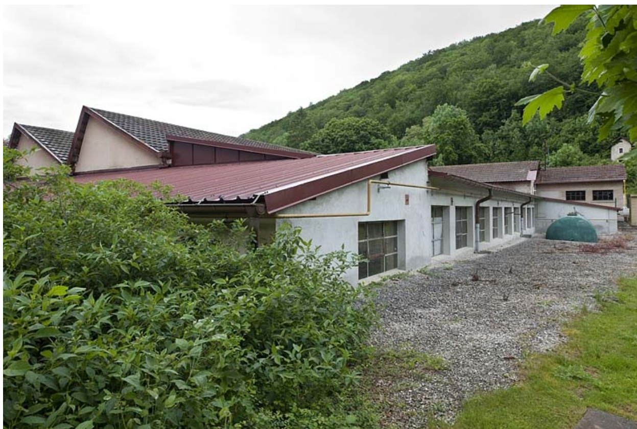
Façade postérieure de l'atelier de fabrication.
