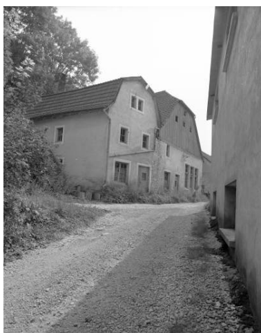
Logement ouvrier et magasin industriel en 1981. Phot. Yves Sancey IVR43_19812500479X
