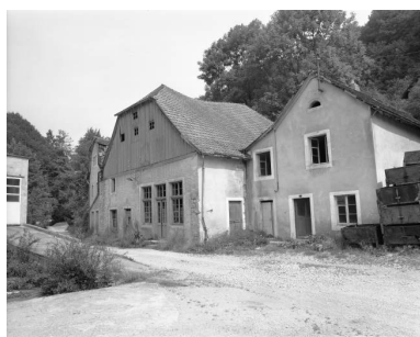
Magasin industriel et conciergerie en 1981. Phot. Yves Sancey IVR43_19812500478X
