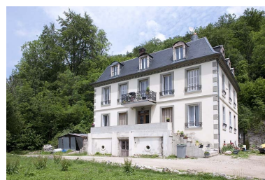
Logement patronal Juillard.
