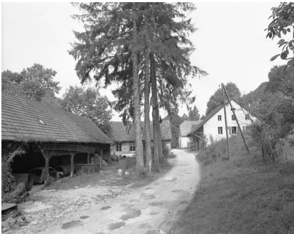
L'entrée du site en 1981.
