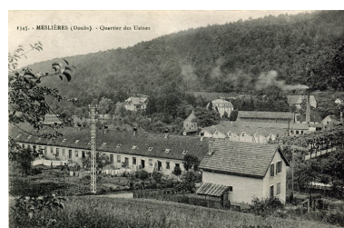
Meslières (Doubs) - Quartier des usines. Phot. Raphaël Favereaux, Autr. Metthez IVR43_20122501375NUC2A
