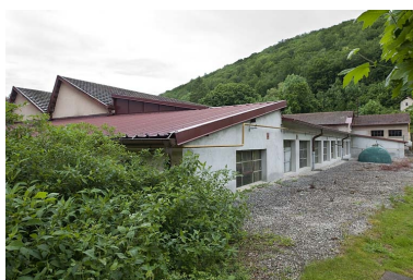
Façade postérieure de l'atelier de fabrication.
