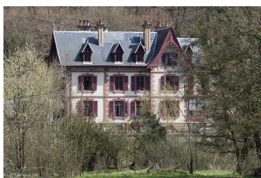
Façade antérieure du logement patronal Sircoulon.
