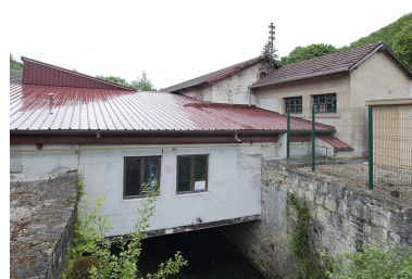
Bâtiment sur l'ancien bief de dérivation.
