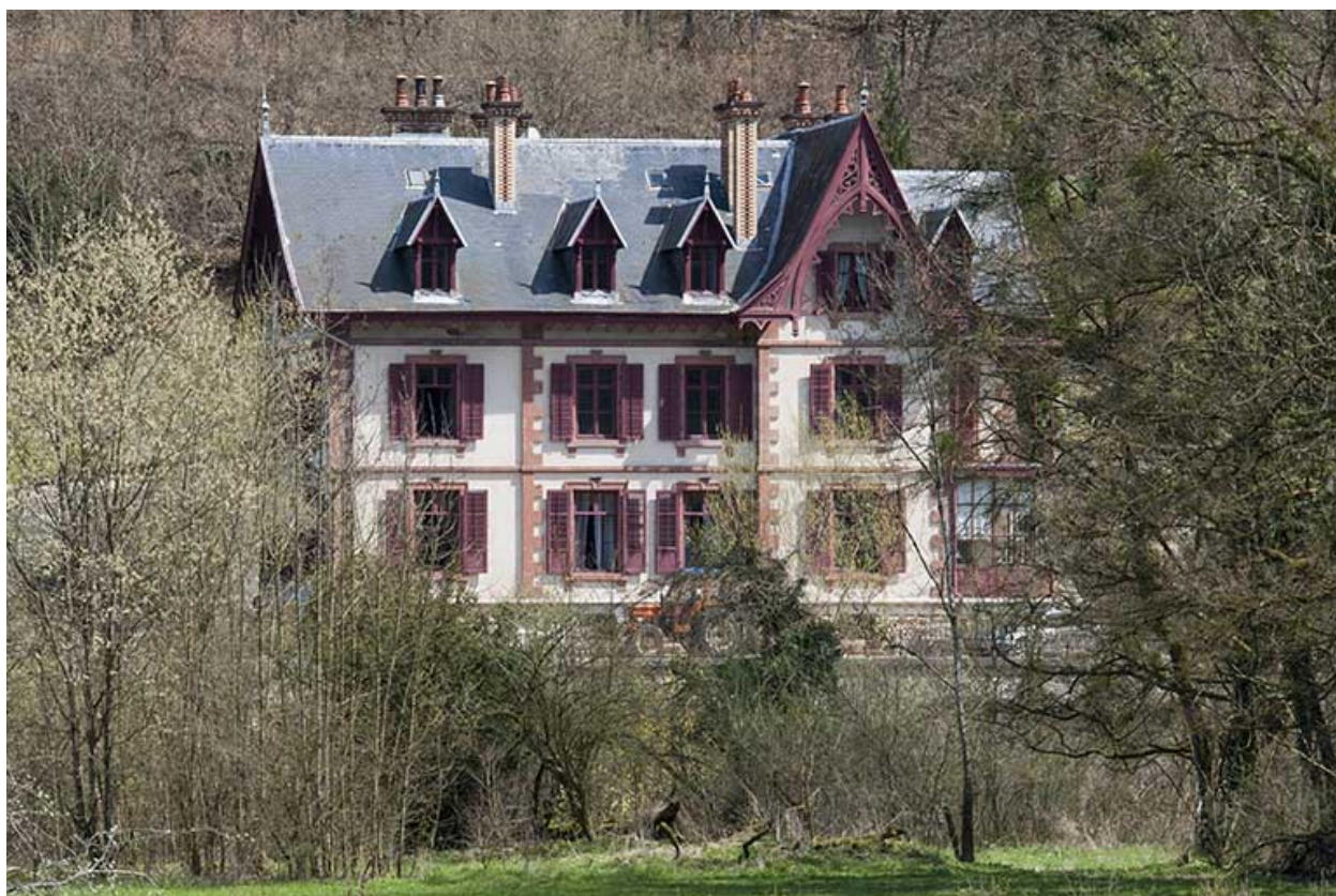
Façade antérieure du logement patronal Sircoulon.
