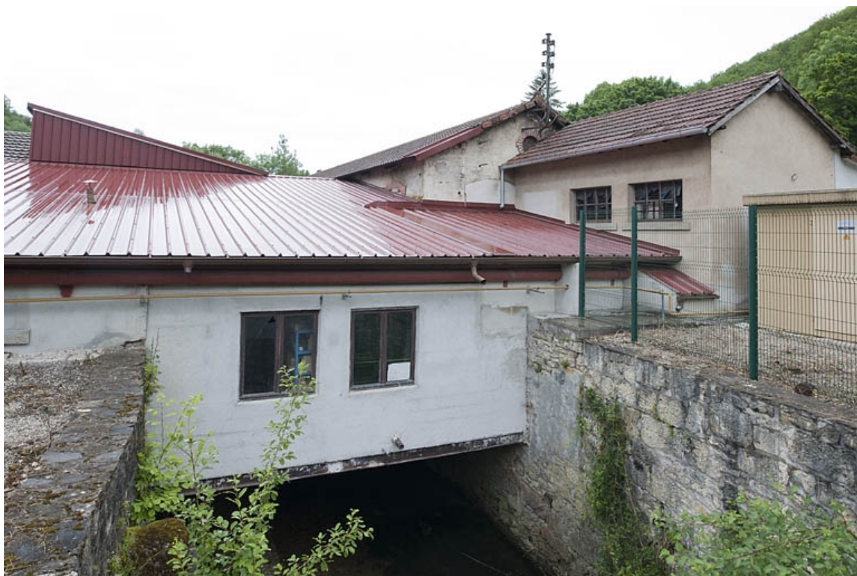
Bâtiment sur l'ancien bief de dérivation.
