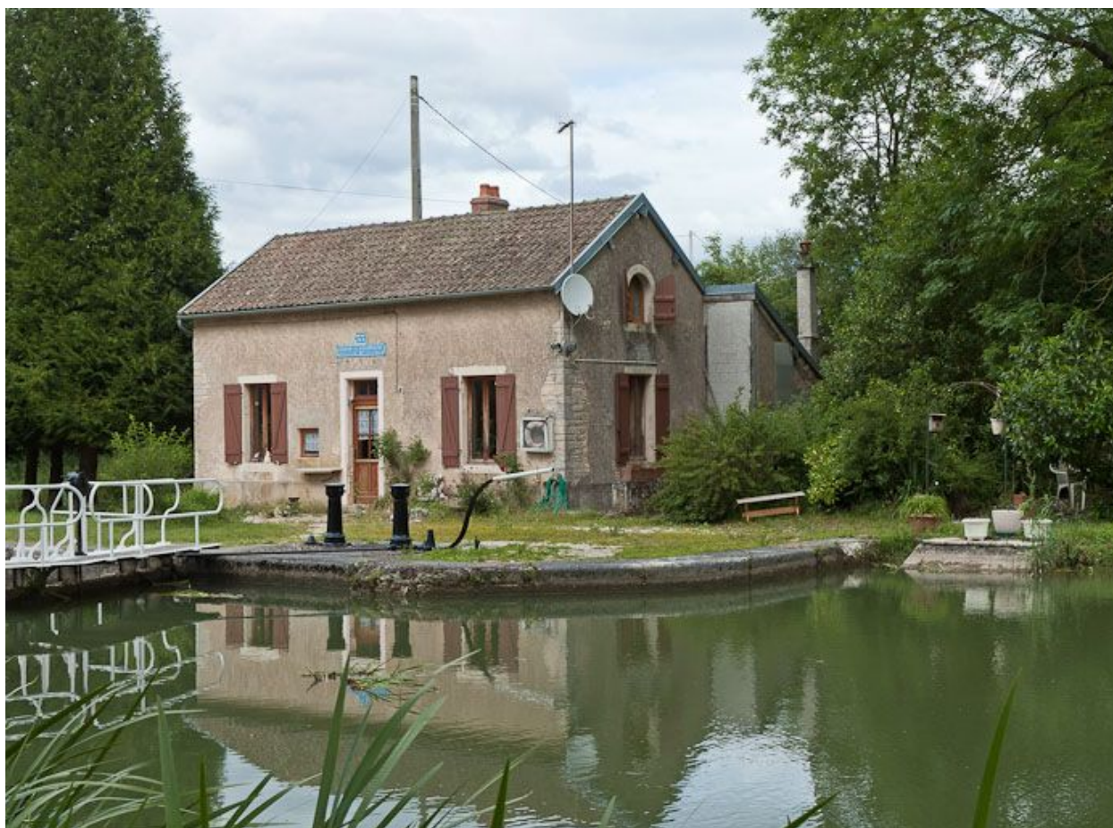
Vue d'ensemble du site d'écluse.
