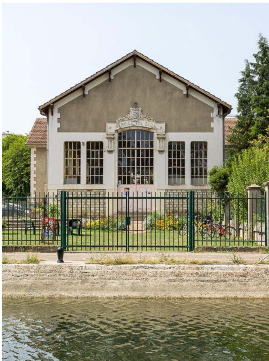
Le bâtiment du moulin : de face.
