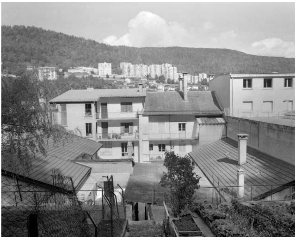
Façade postérieure des bâtiments.
