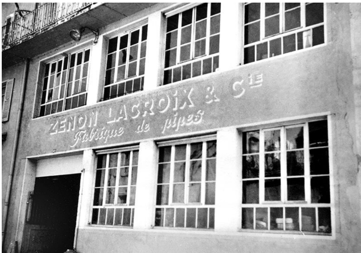
Façade antérieure du n° 8 bis.
