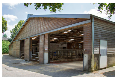
Pignon nord de l'étable ouest. Phot. Sonia Dourlot IVR43_20142501000NUC2A
