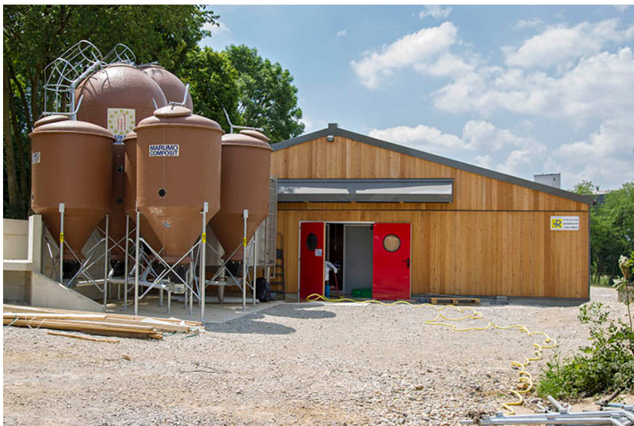
Pignon nord de la porcherie.
