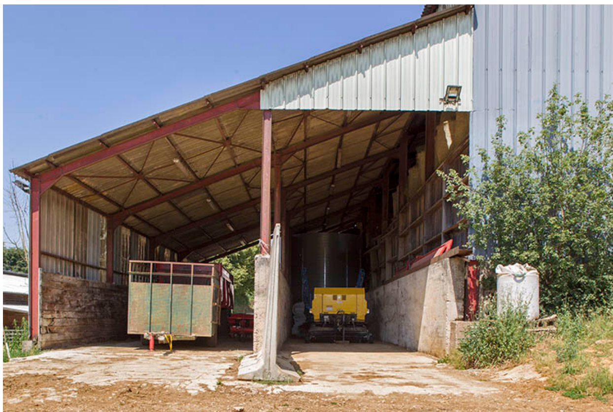
Appenti à l'ouest de l'entrepôt agricole.
