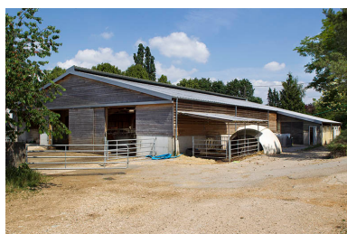
L'étable ouest vue de trois-quart sud-est. Phot. Sonia Dourlot IVR43_20142501003NUC2A
