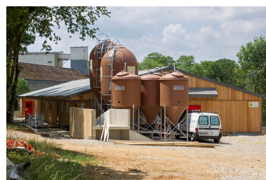
La porcherie vue du nord-est. Phot. Sonia Dourlot IVR43_20142501011NUC2A
