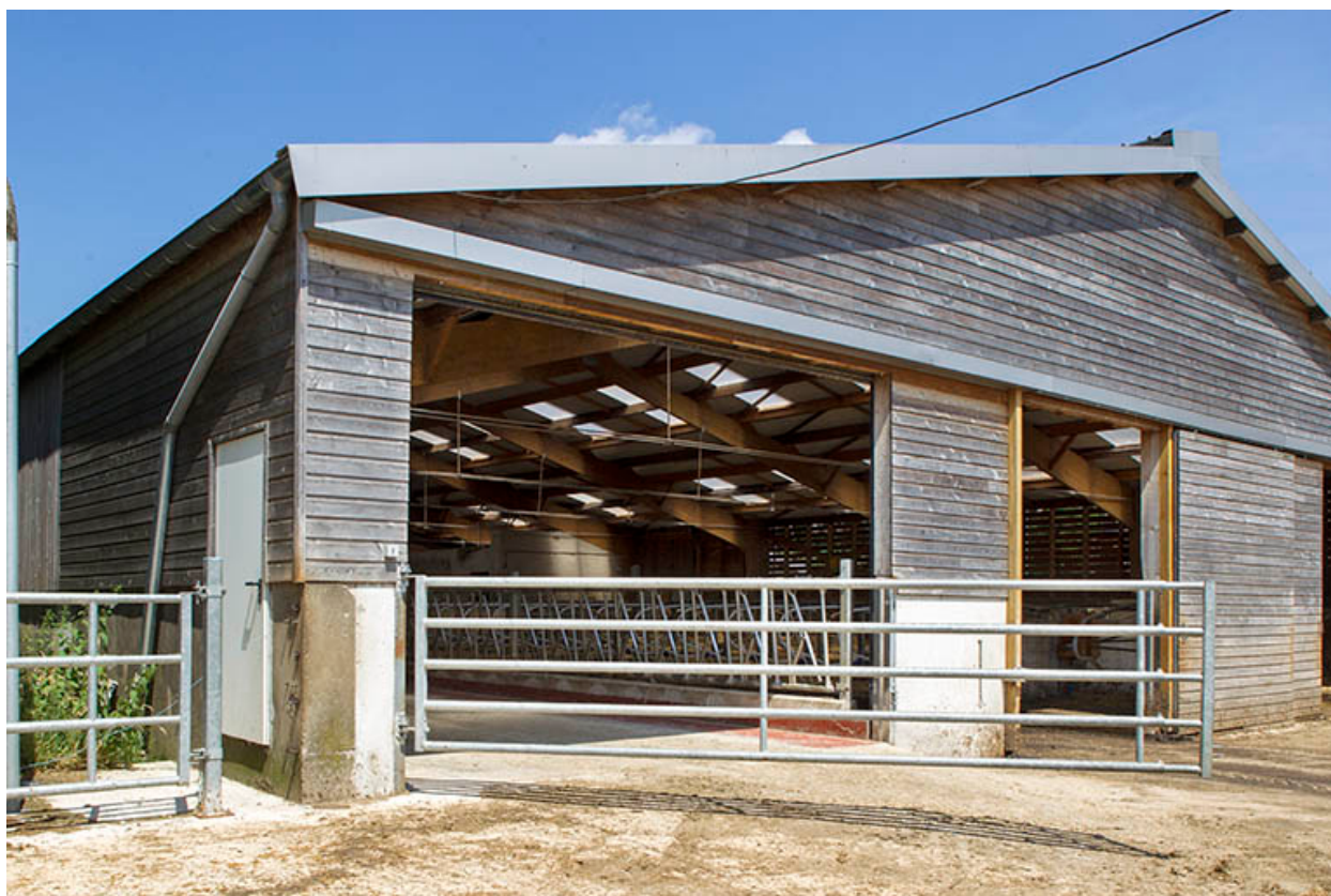
Angle sud-ouest de l'étable ouest.
