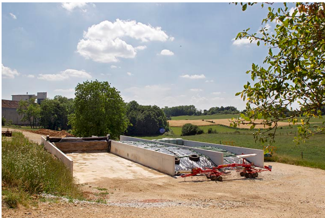
Au sud de l'étable ouest.
