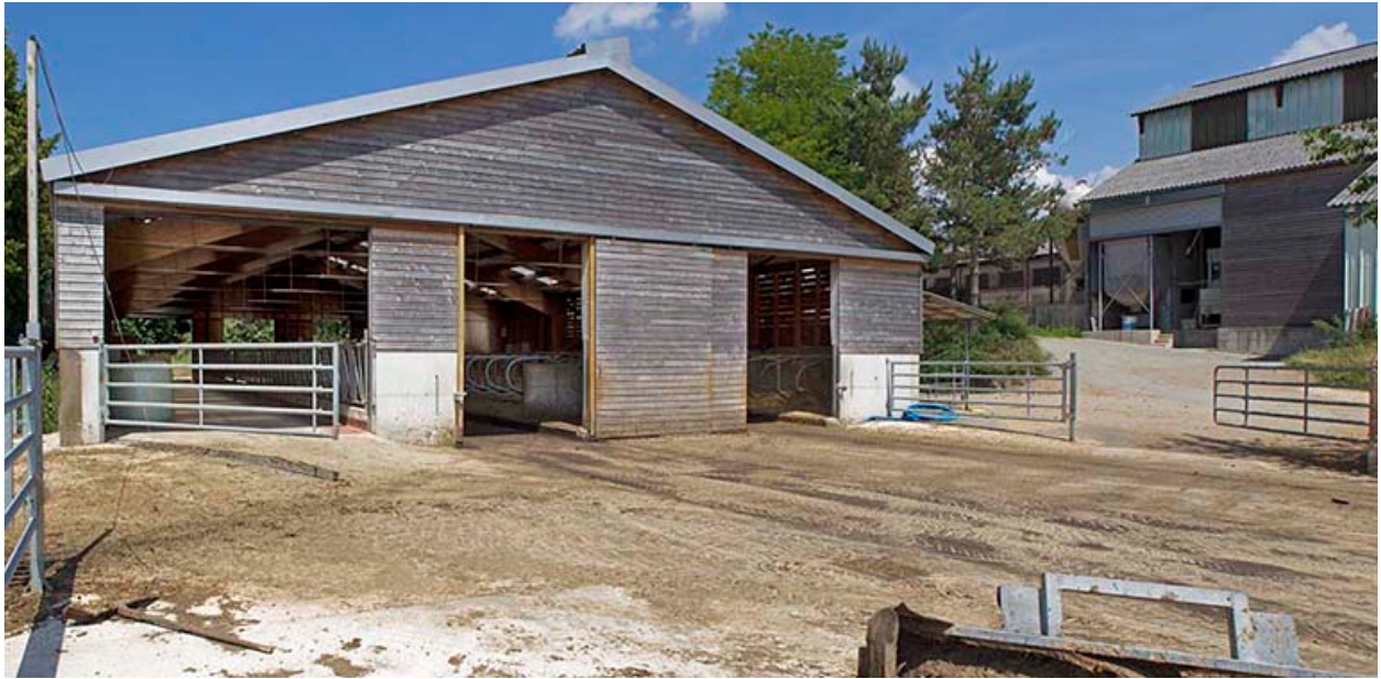
Pignon sud de l'étable ouest.
