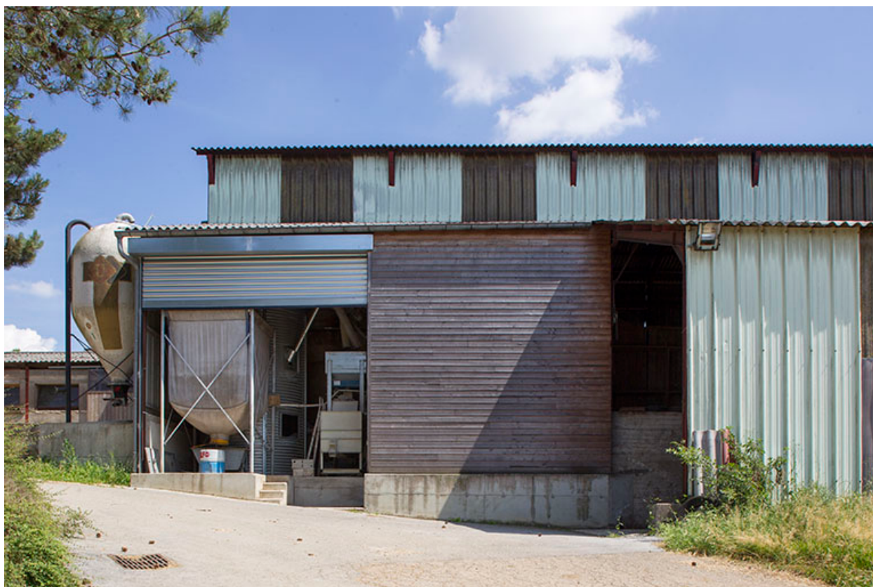
Silos, moulins à l'ouest de l'entrepôt agricole.
