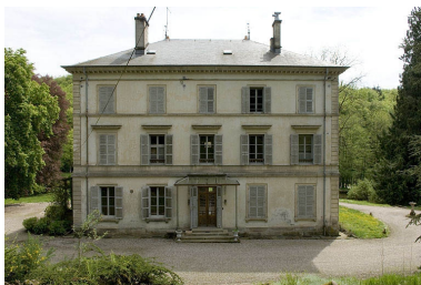
Façade postérieure. Phot. Jérôme Mongreville IVR43_20067000313NUCA
