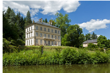
Vue générale. Phot. Sonia Dourlot IVR43_20157001070NUC2A
