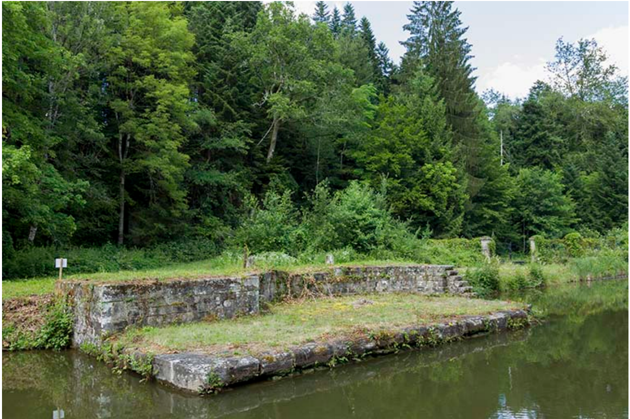
Ancien emplacement du pont tournant.
