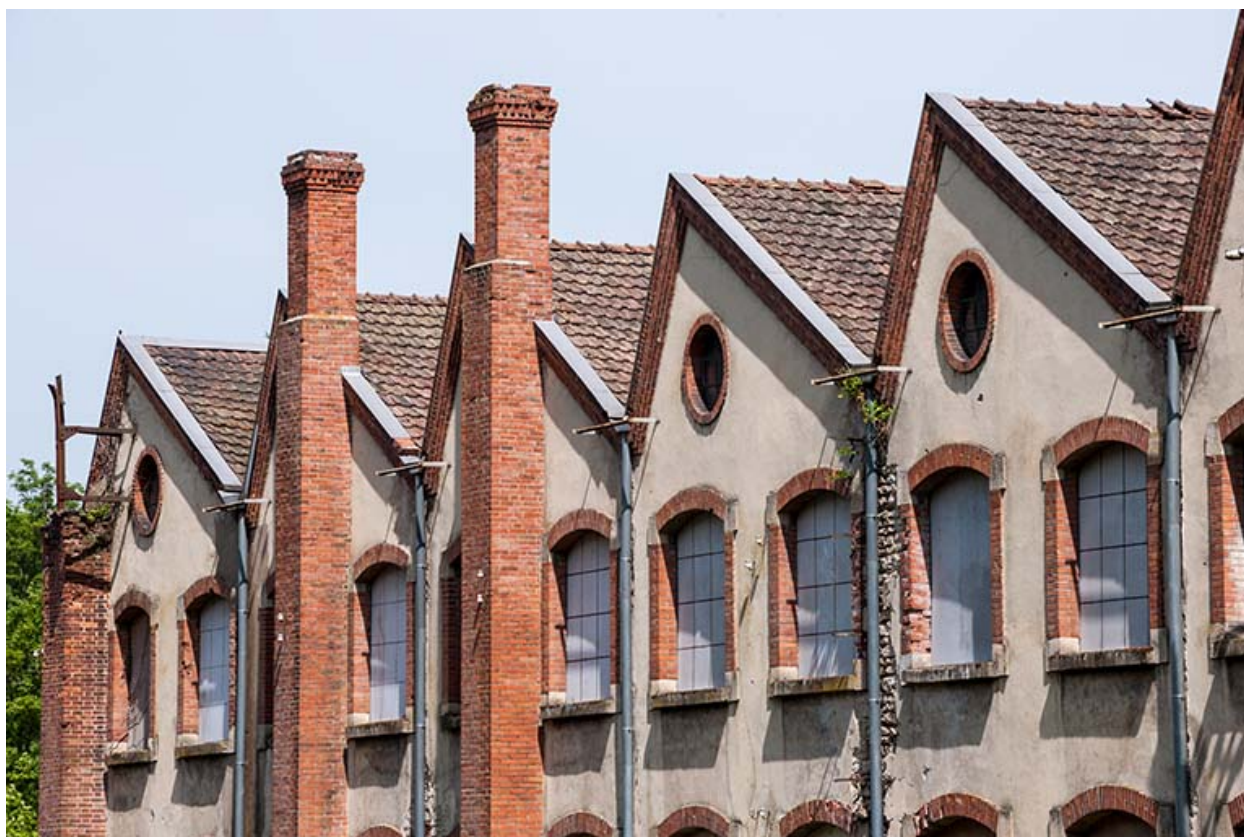
Détail des pignons de l'atelier de fabrication.
