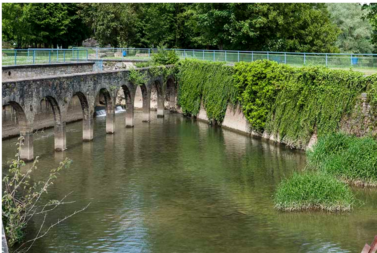
L'ancien canal de fuite.
