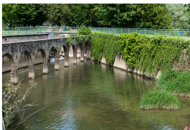
L'ancien canal de fuite. Phot. Jérôme Mongreville IVR43_20142501333NUC4A
