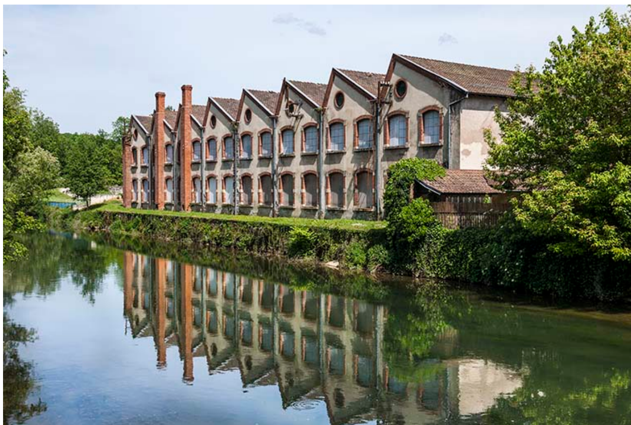
Façade ouest de l'atelier de fabrication.
