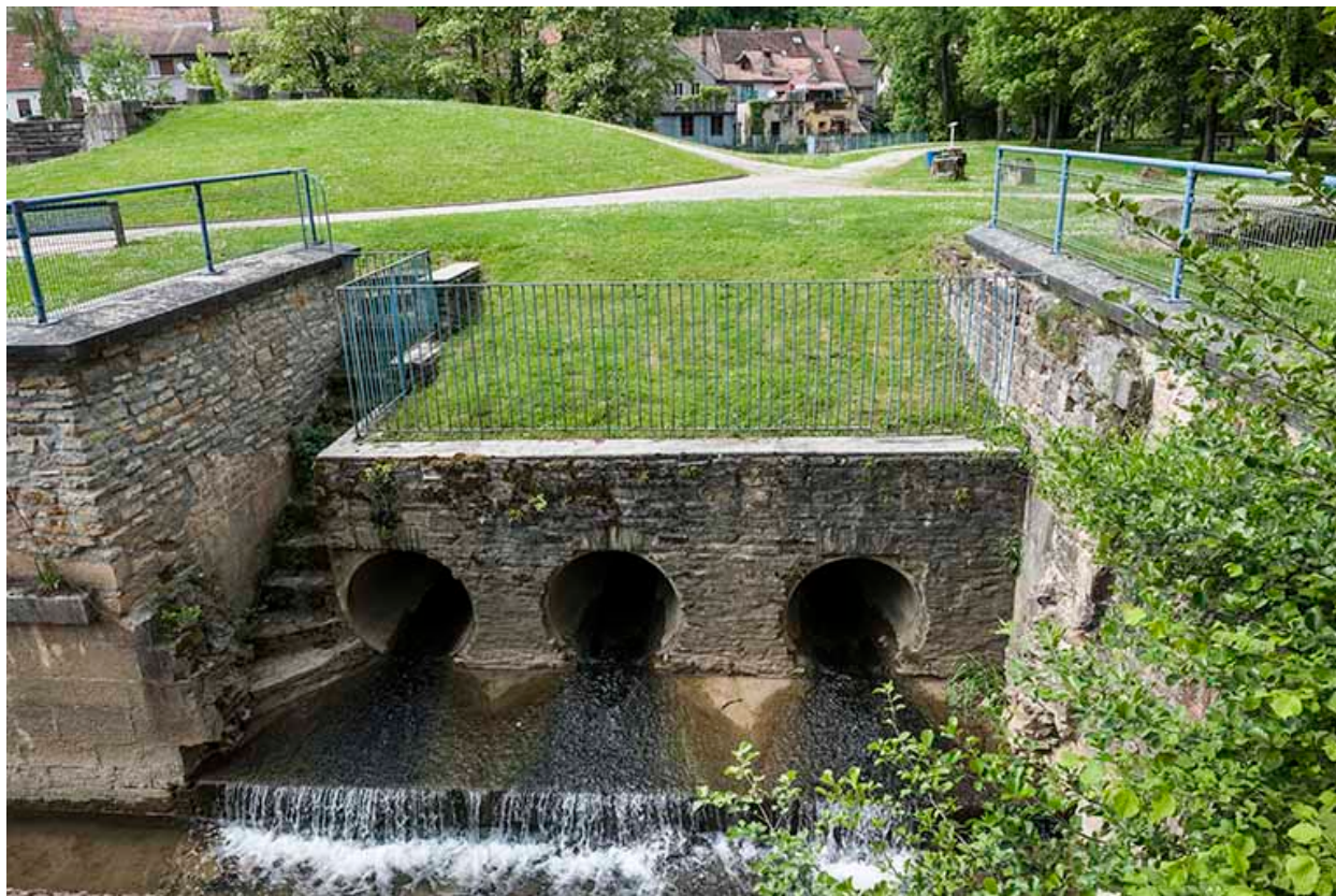
Vestiges des évacuations des turbines hydrauliques.
