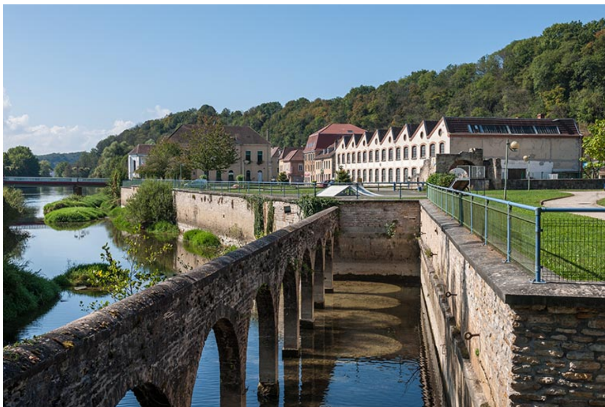
Vue d'ensemble depuis le nord du site.
