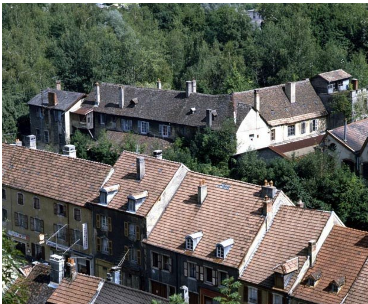
Logement patronal vu depuis l'ouest en 1986.
