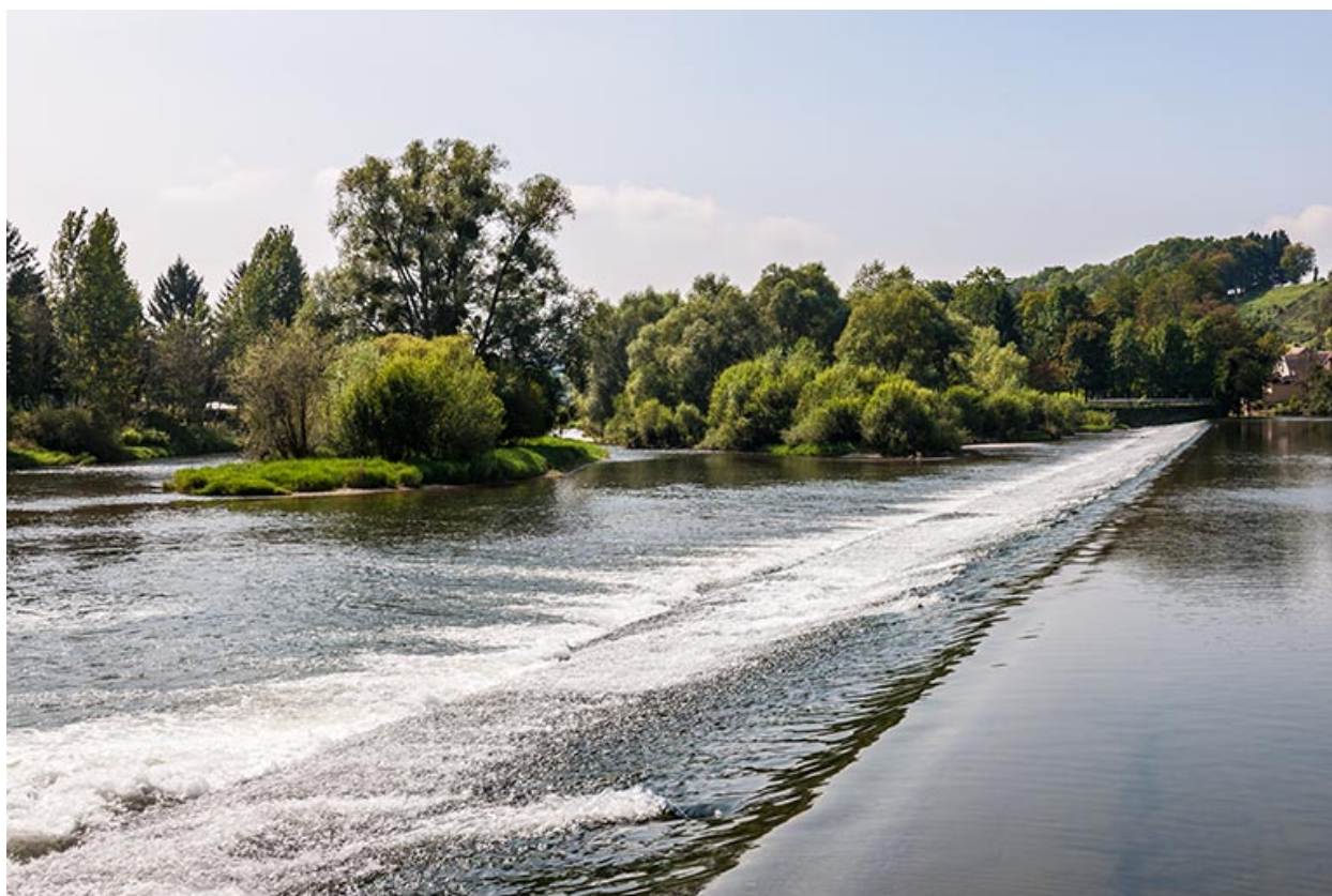
Barrage sur le Doubs.
