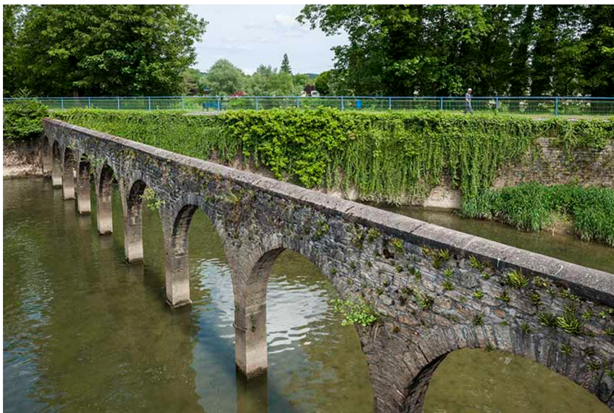
Arcades enjambant l'ancien canal de fuite.
