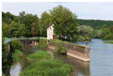
L'ancien canal de fuite et le transformateur. Phot. Jérôme Mongreville
