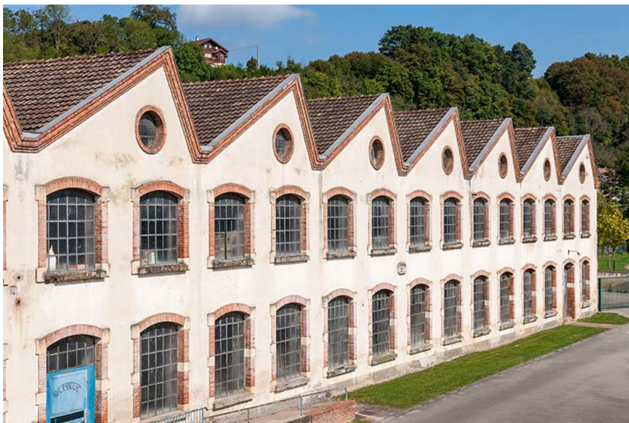
Façade est de l'atelier de fabrication.
