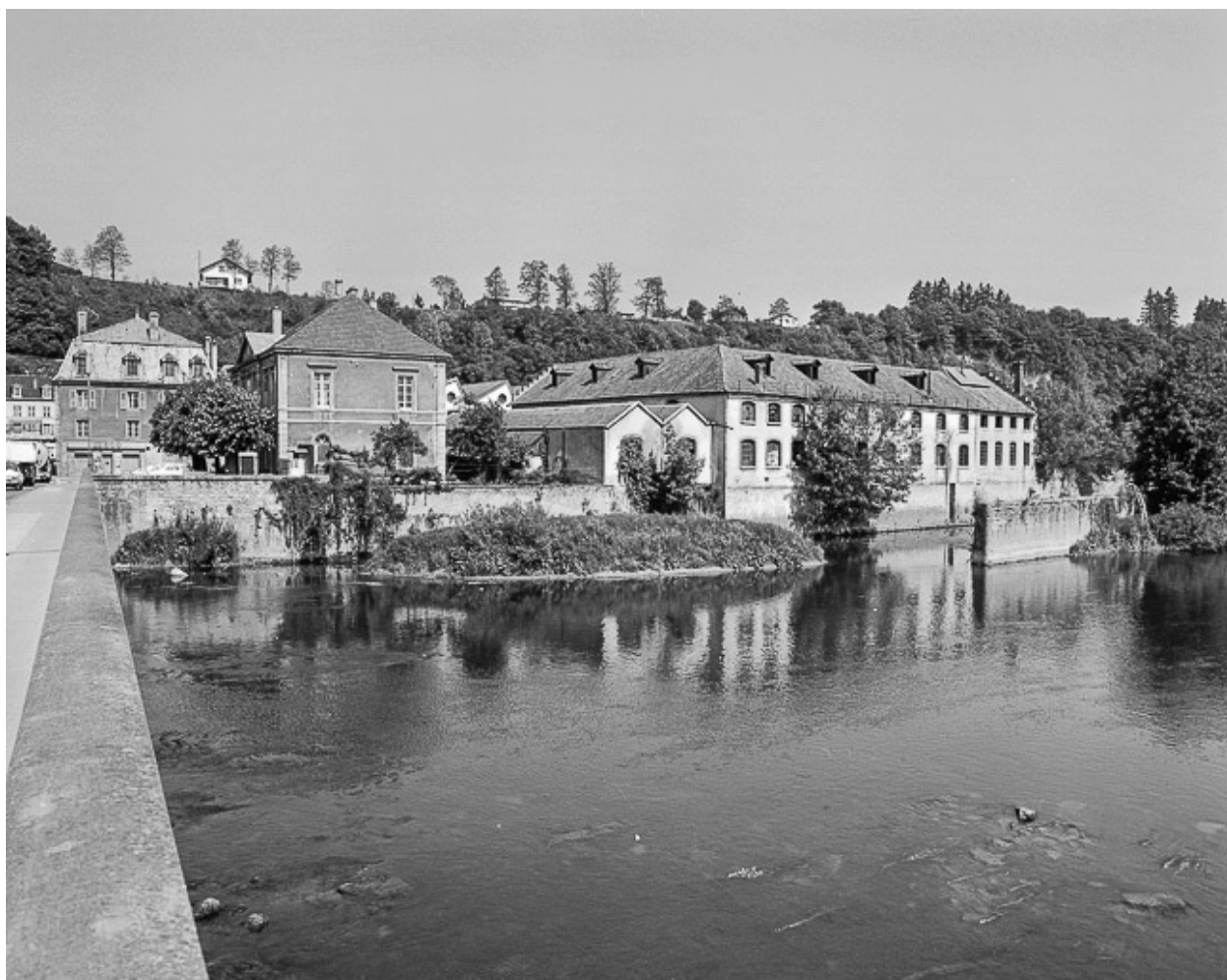
Vue d'ensemble depuis le pont en 1976.
