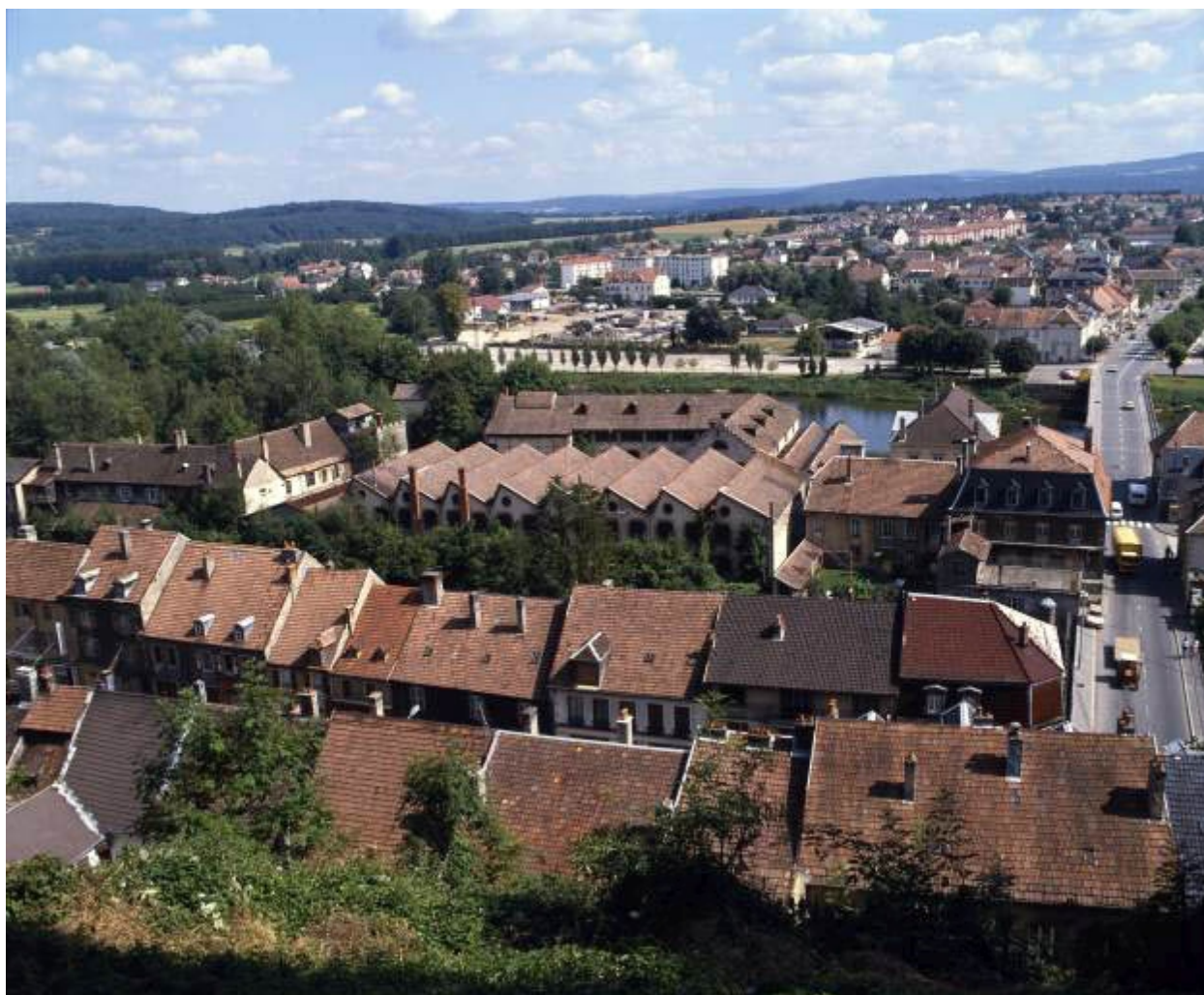
Vue plongeante depuis l'ouest en 1986.
