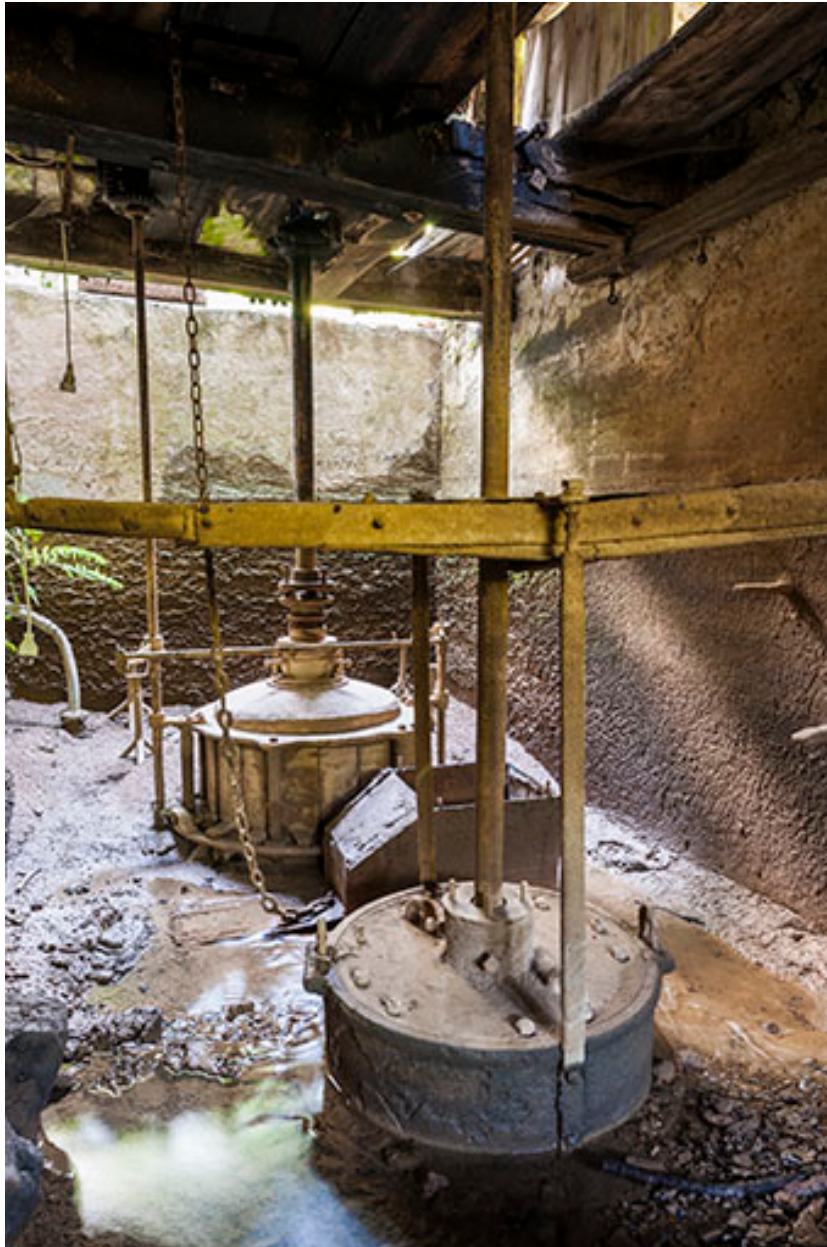
La chambre d'eau des turbines.
