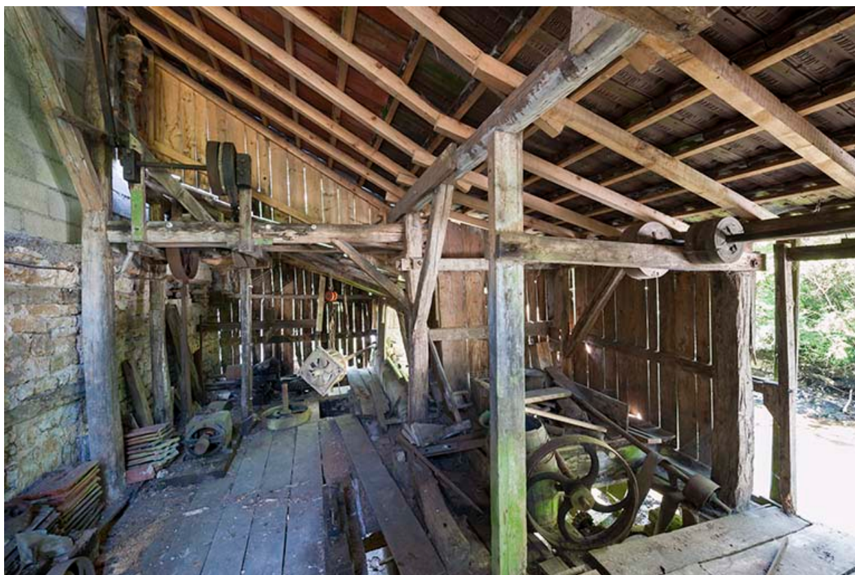
Vue intérieure du bâtiment d'eau.
