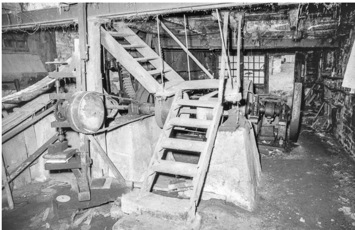
Vue d'ensemble de l'atelier depuis l'ouest en 1980.
