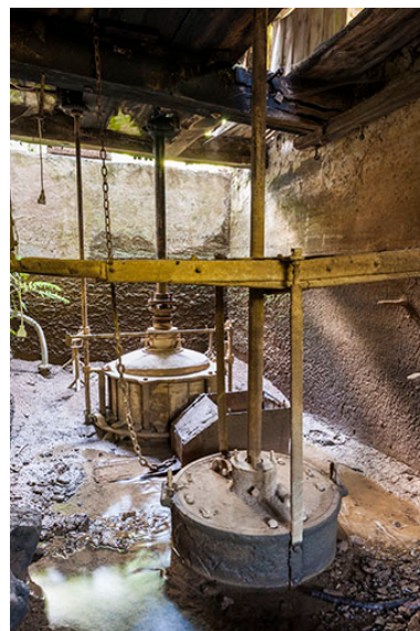
La chambre d'eau des turbines.
