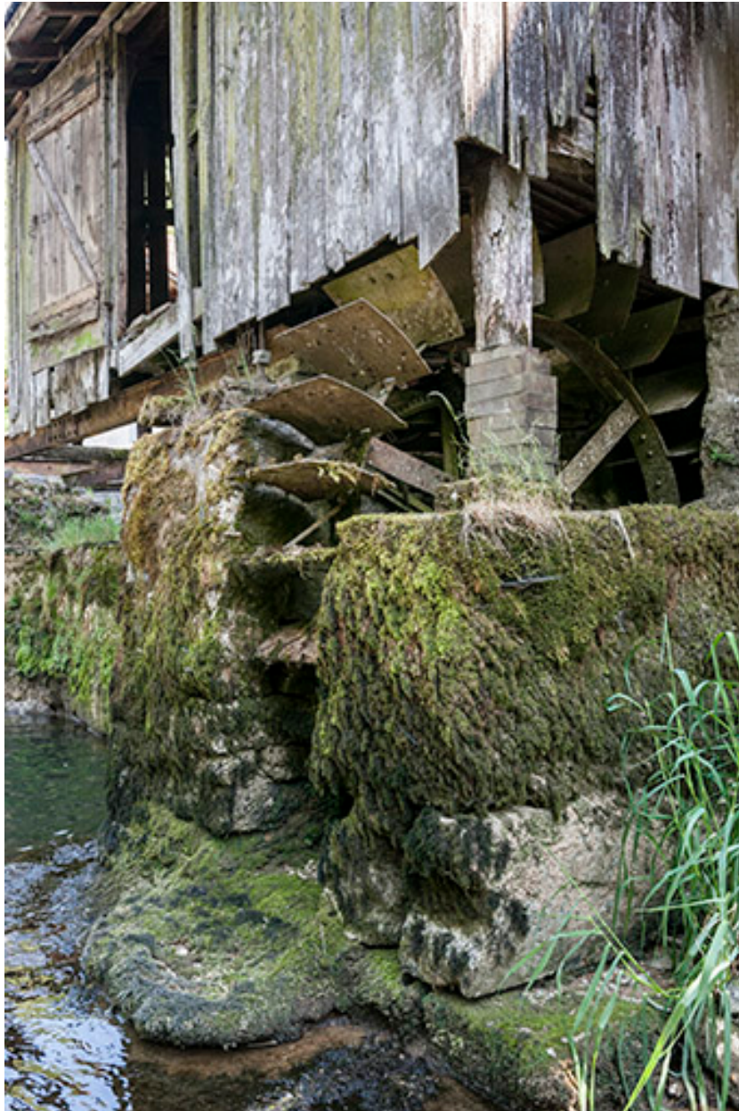
Bâtiment d'eau. Roue en dessous.
