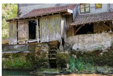
Façade nord. Le bâtiment d'eau. Phot. Jérôme Mongreville IVR43_20152501256NUC4A
