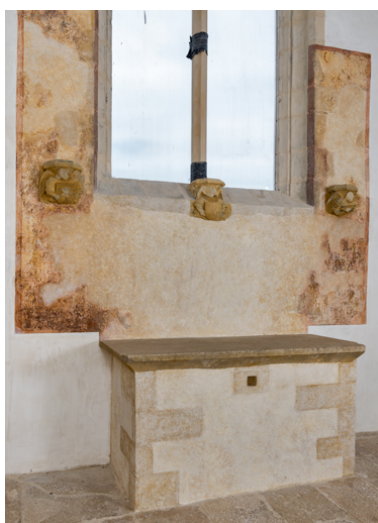
Mur nord de la chapelle. Phot. Pierre-Marie Barbe-Richaud IVR26_20237100337NUC4A
