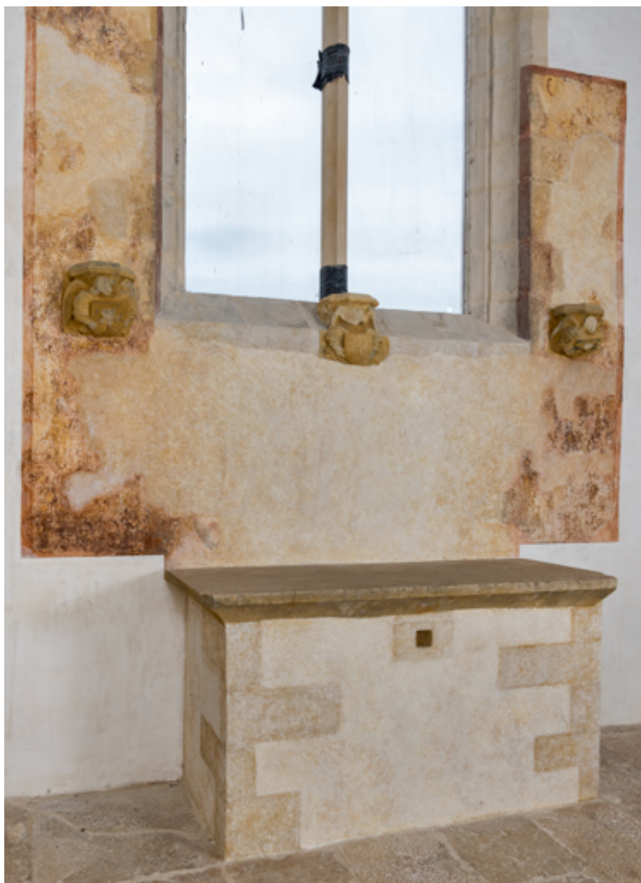
Mur nord de la chapelle.
