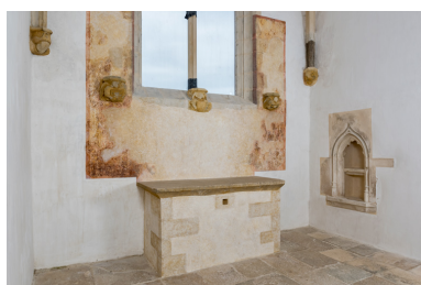
Mur nord de la chapelle. Phot. Pierre-Marie Barbe-Richaud IVR26_20237100338NUC4A
