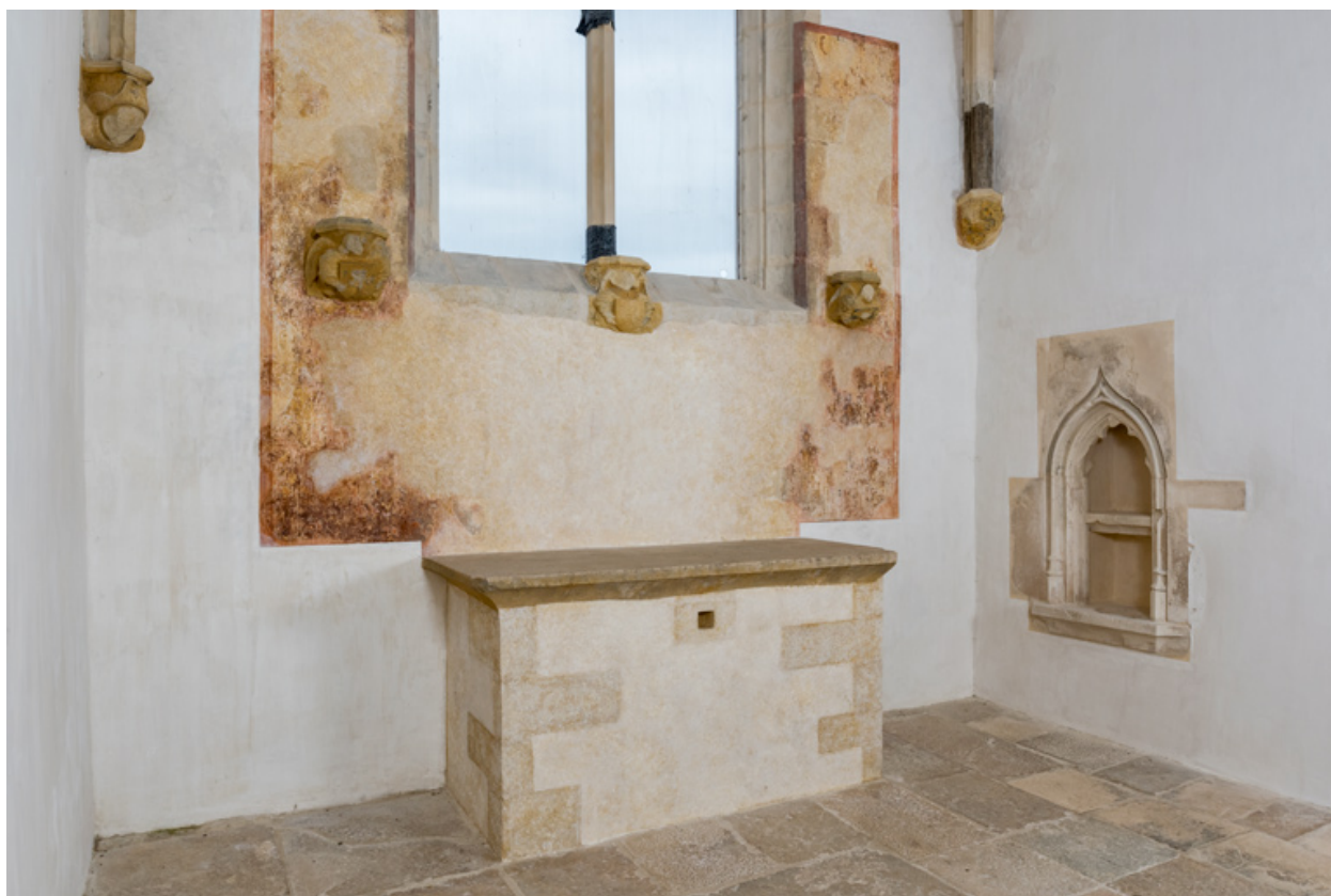
Mur nord de la chapelle.
