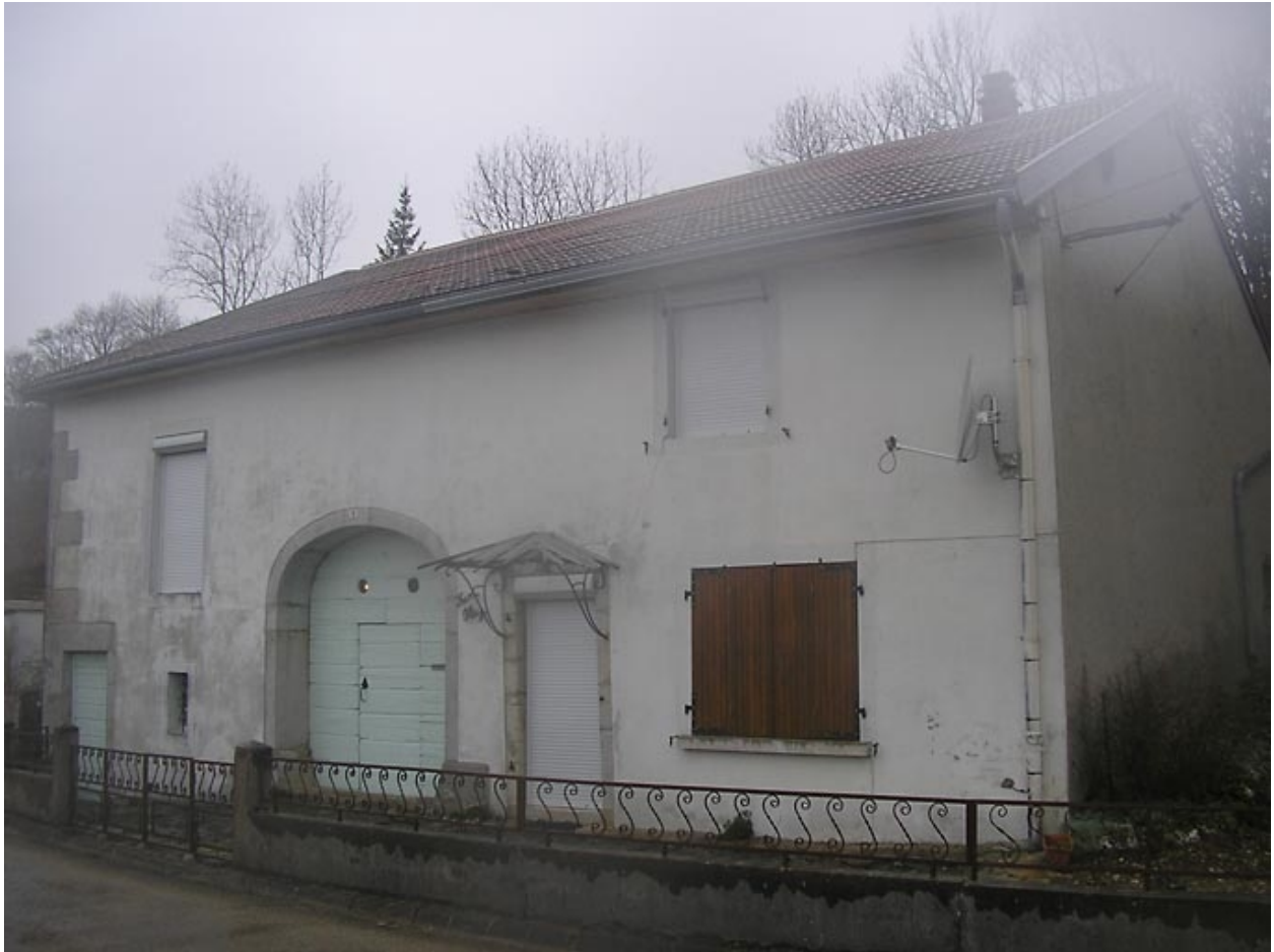
Vue de trois quarts sur façade antérieure.
