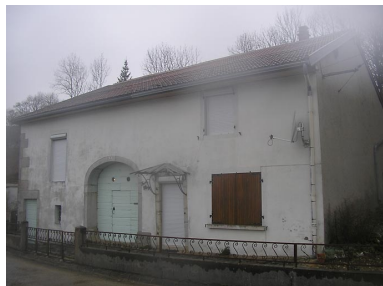
Vue de trois quarts sur façade antérieure.
