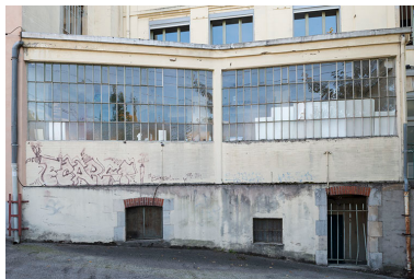
Verrière nord d'un atelier. Phot. Jérôme Mongreville IVR43_20182500581NUC4A
