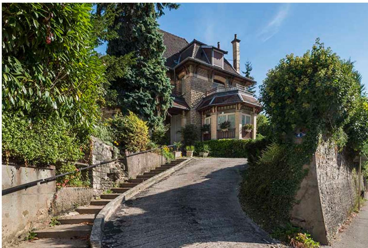
Logement patronal, depuis la rue.
