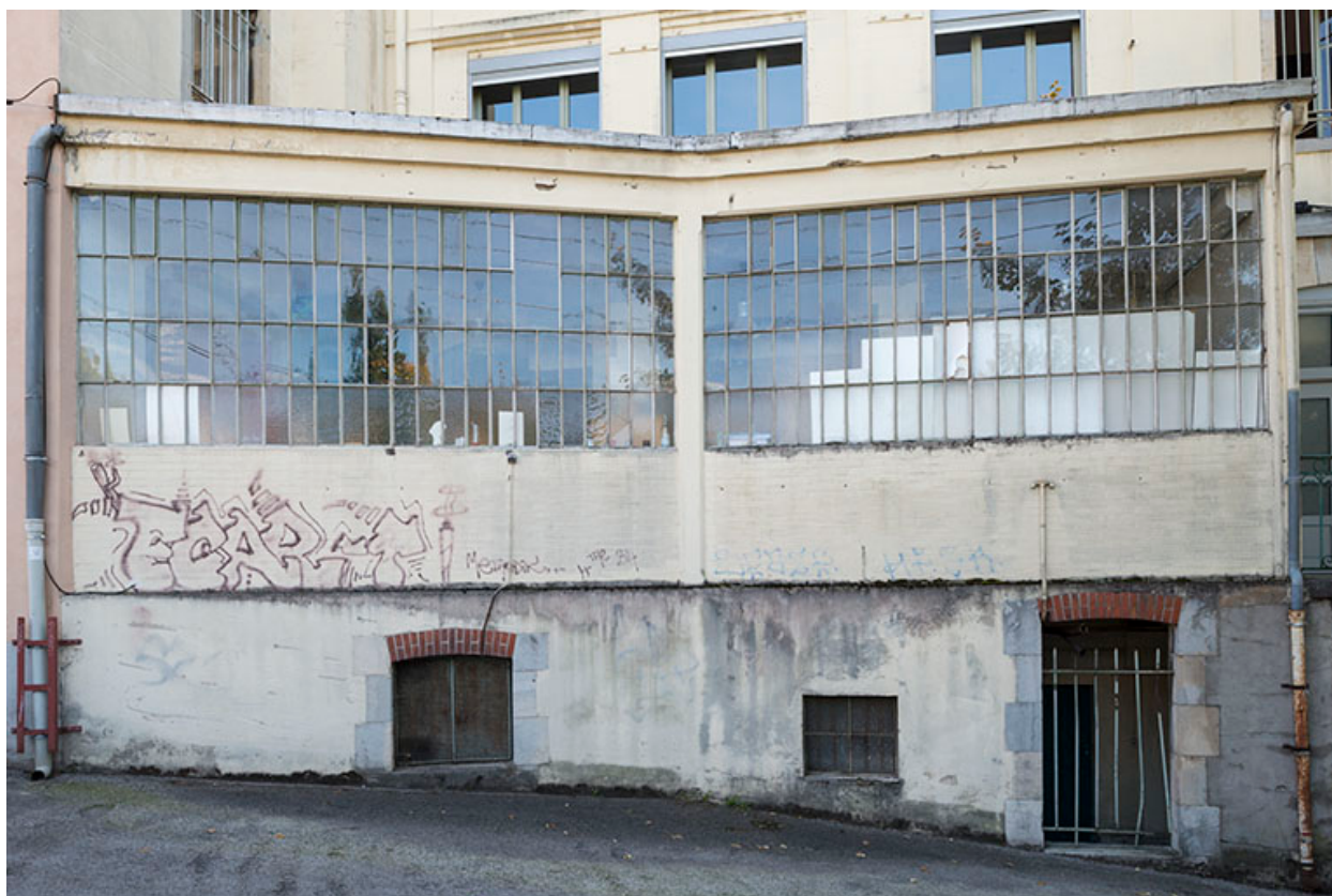
Verrière nord d'un atelier.
