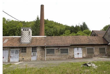
Façade sud-ouest de l'atelier de polissage. Phot. Jérôme Mongreville IVR43_20057000201NUCA
