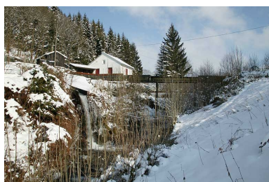
Le déversoir et le canal d'amenée. Phot. Jérôme Mongreville IVR43_20057000205NUCA
