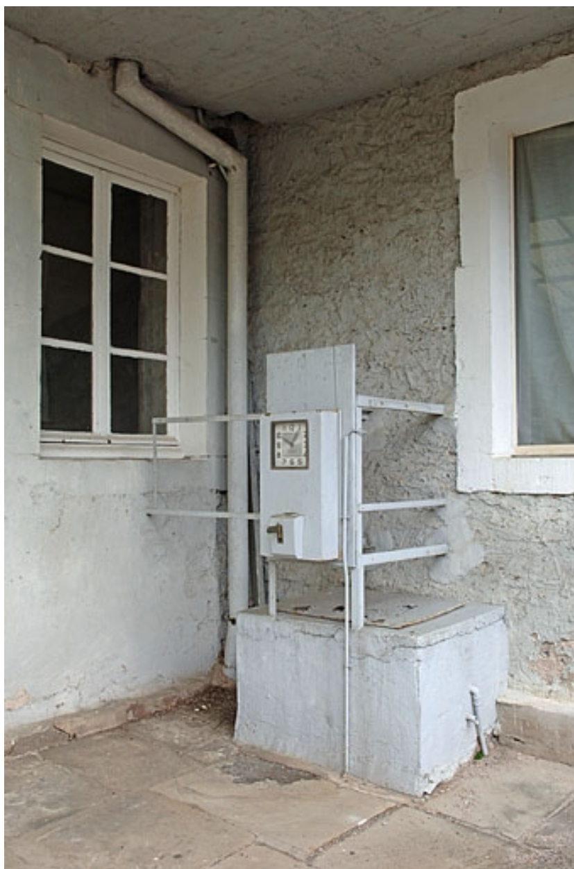
Entrée des bureaux et appareil de pointage.
