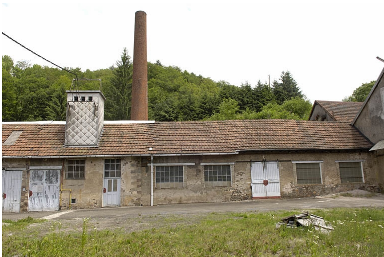
Façade sud-ouest de l'atelier de polissage.
