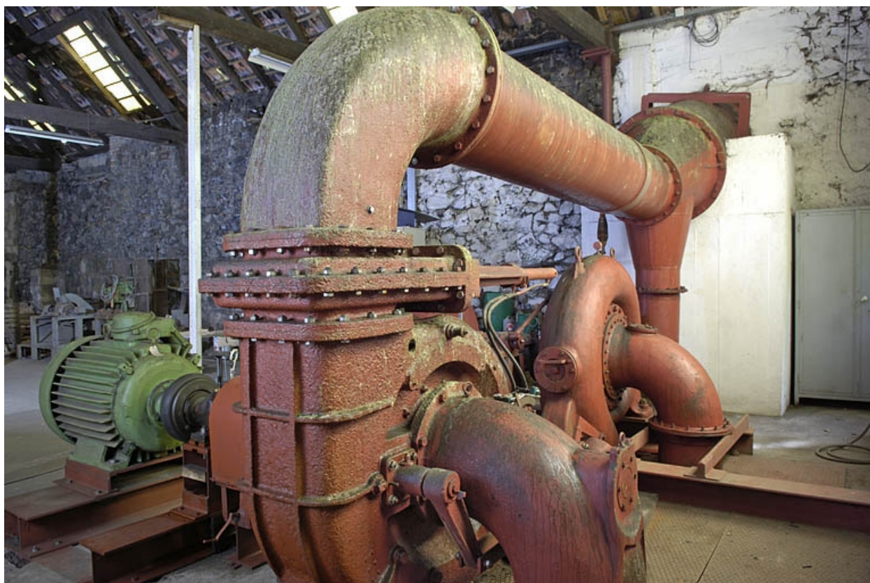
Forge du Haut. Vue rapprochée des turbines.
