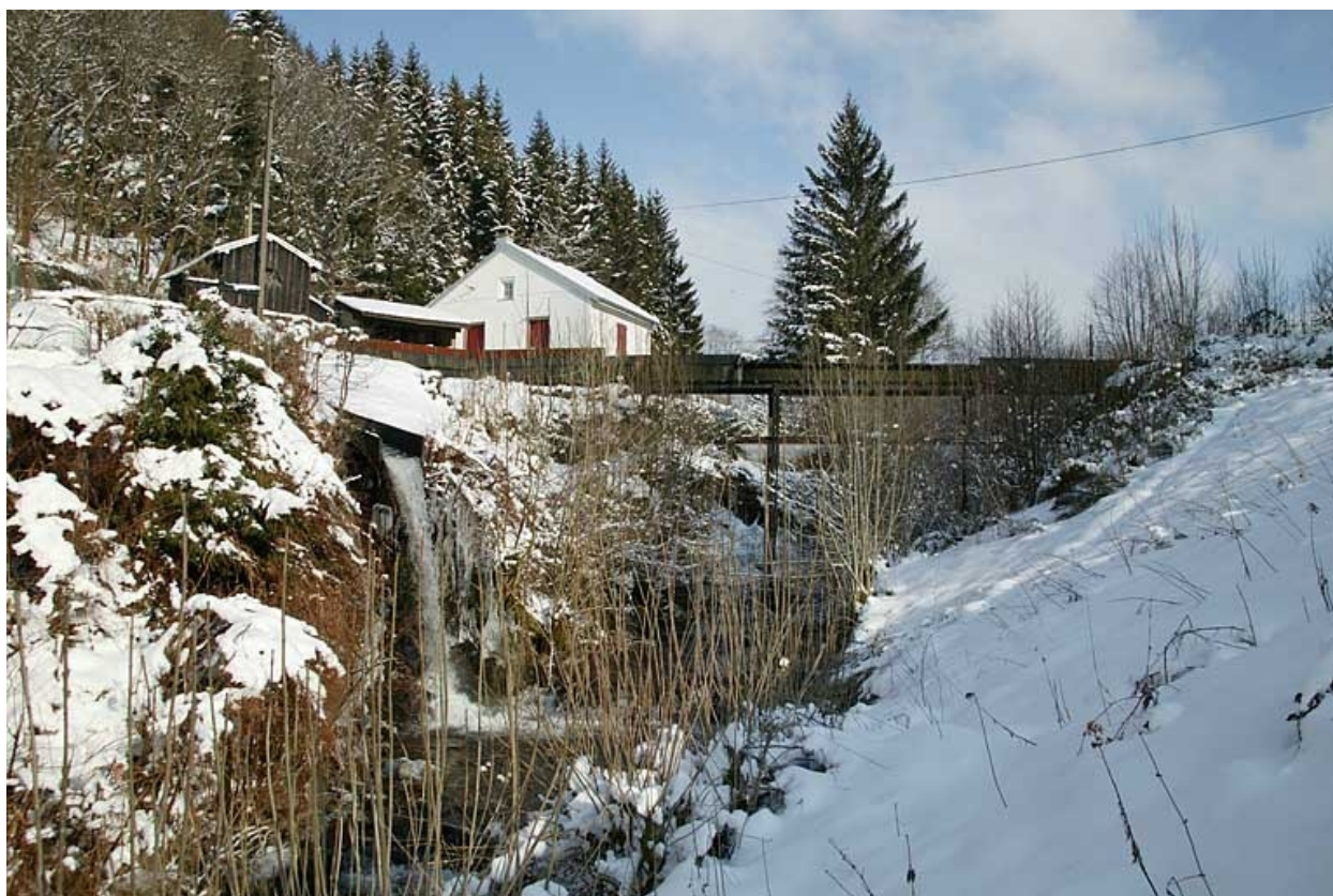
Le déversoir et le canal d'amenée.
