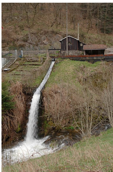
Le déversoir du bassin de retenue. Phot. Jérôme Mongreville IVR43_20057000206NUCA
