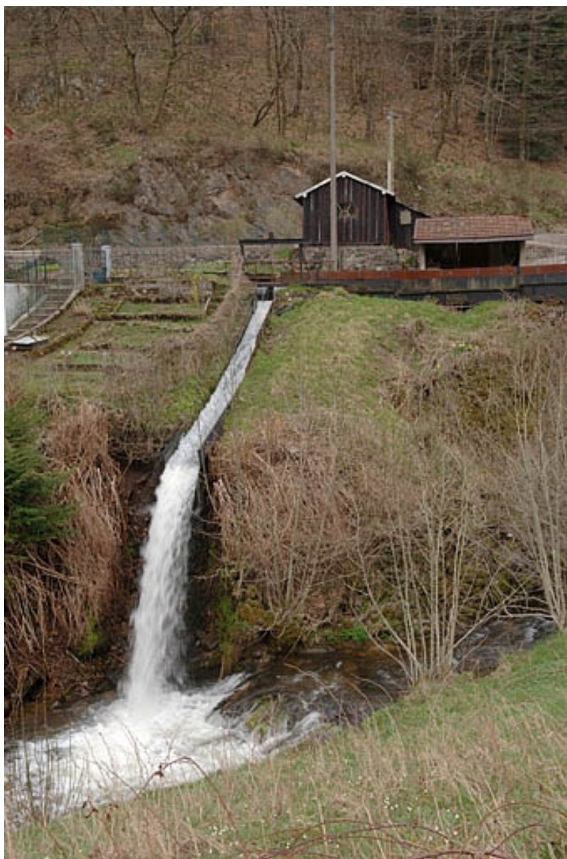
Le déversoir du bassin de retenue.
