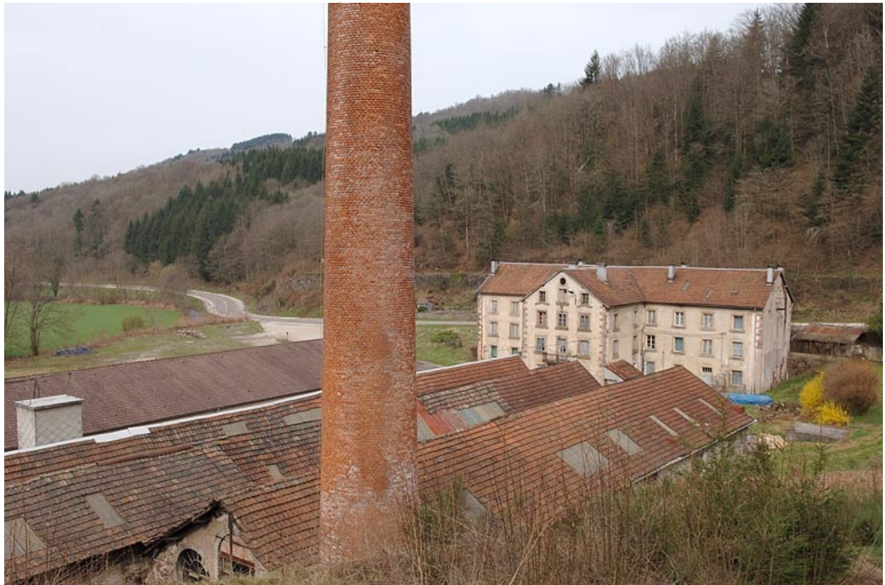
Vue plongeante depuis le nord-est.
