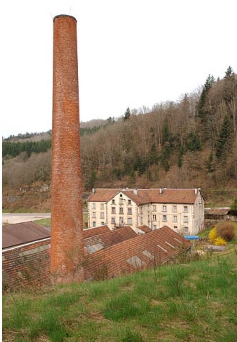
Vue plongeante depuis le nord-est (cadrage vertical).
