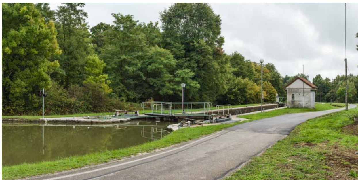
Vue d'ensemble du site d'écluse.
