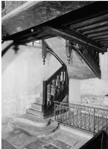
Escalier. Phot. Michel Rosso IVR26_19792101020V
