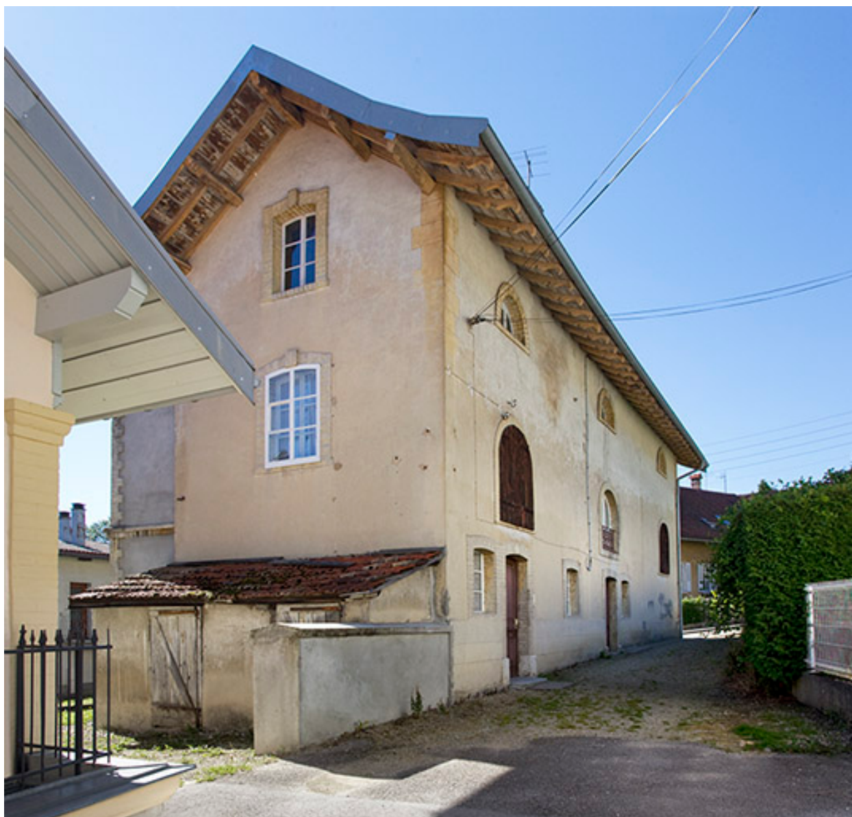
Façades postérieure et latérale droite.
