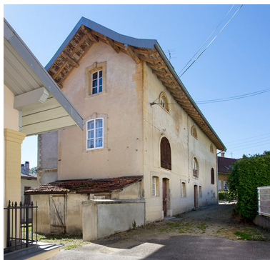
Façades postérieure et latérale droite.
