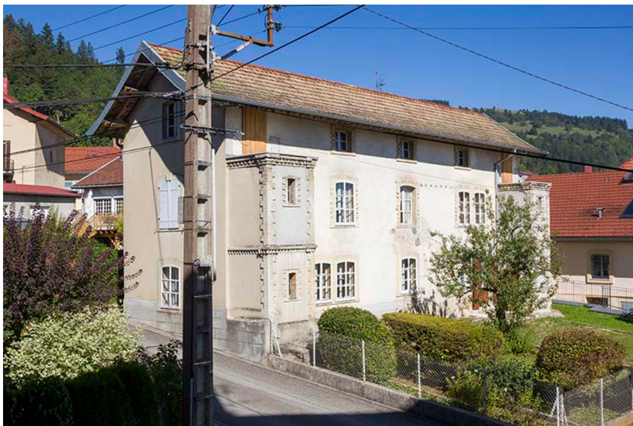
Façades antérieure et latérale gauche.
