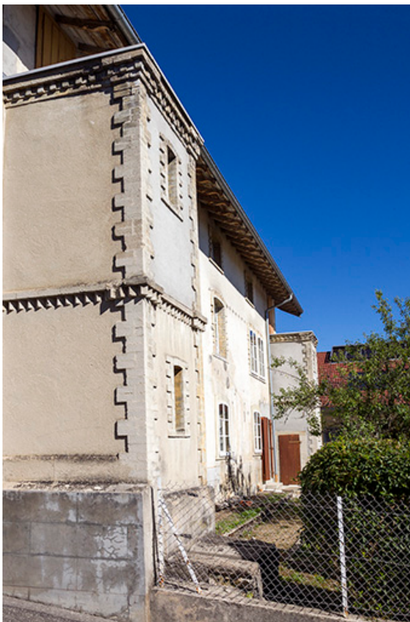
Façade antérieure, vue en enfilade.
