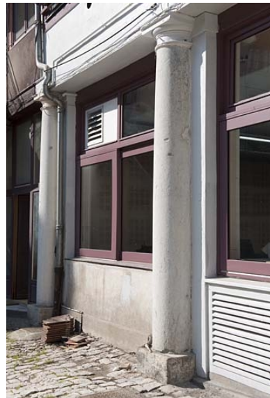
Détail du portique de l'aile sur cour. Phot. Jérôme Mongreville IVR43_20112500058NUC4A
