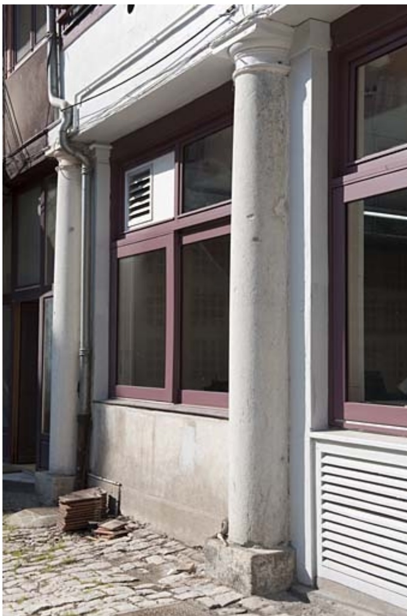
Détail du portique de l'aile sur cour.
